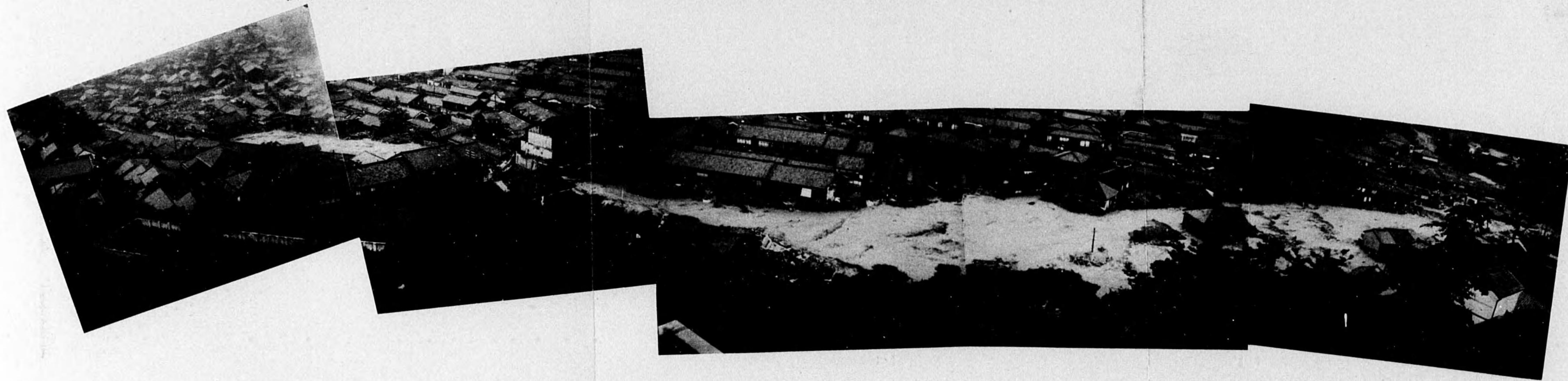
95) 海洋氣象臺屋上より宇治川(暗渠にて其上は道路)の氾濫を望む
