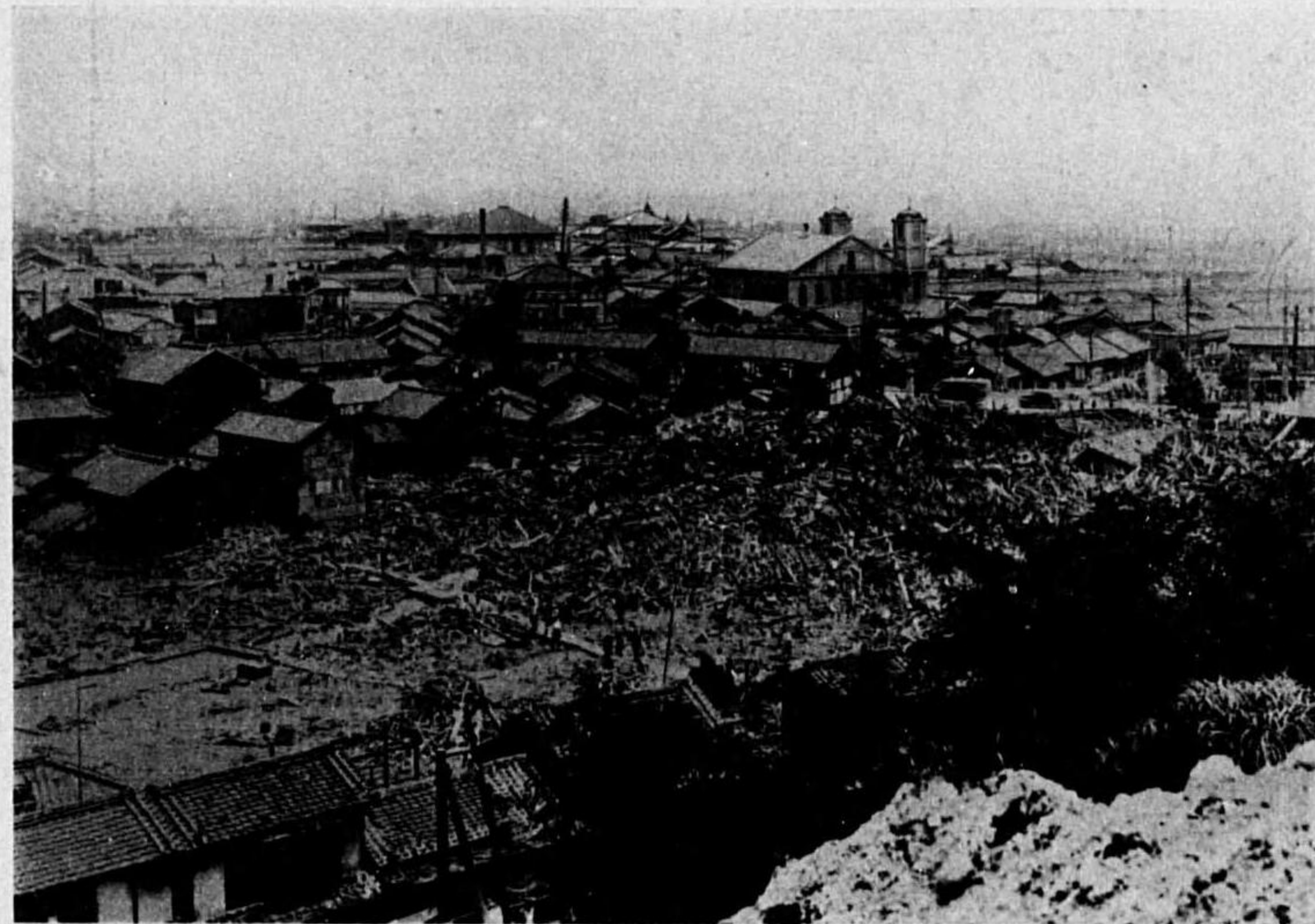
75) 市電橋に塞つた流木と潰家 7月10日棚橋撮
