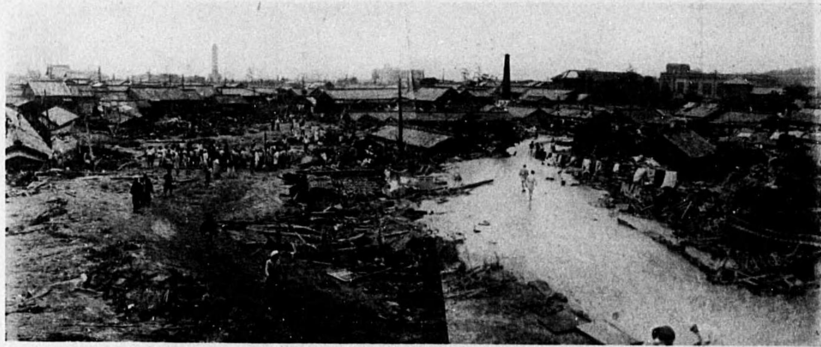
77) 荒田三丁目附近の被害 (水害前は全部人家にて充塞され川はなかりし所) 7月6日撮
