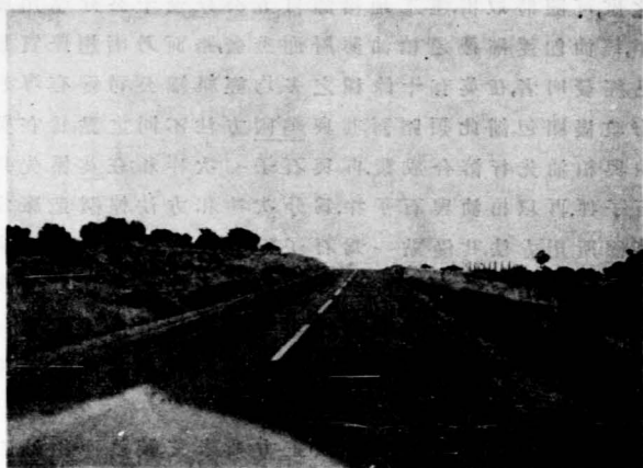
第二圖 美國之冷鋪柏油路(此段路繞過山頂,路中劃白線,所以強制車輛於到山頂時分道行駛,如此視線即有為山頂遮斷之時,亦無與迎面車輛相撞之虞。就危險處局部劃分道線,所費工料不多而收效實宏,法至善也。)
