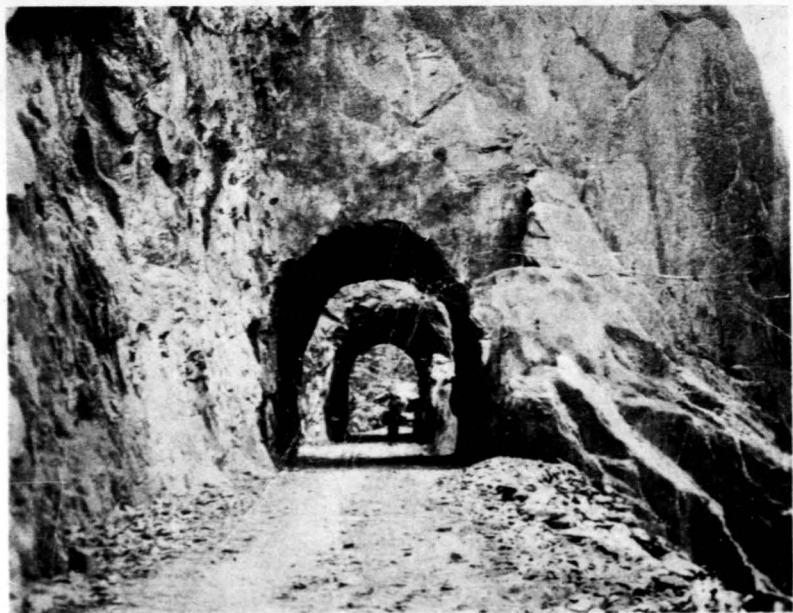
西漢公路鷓頭關山洞工程
