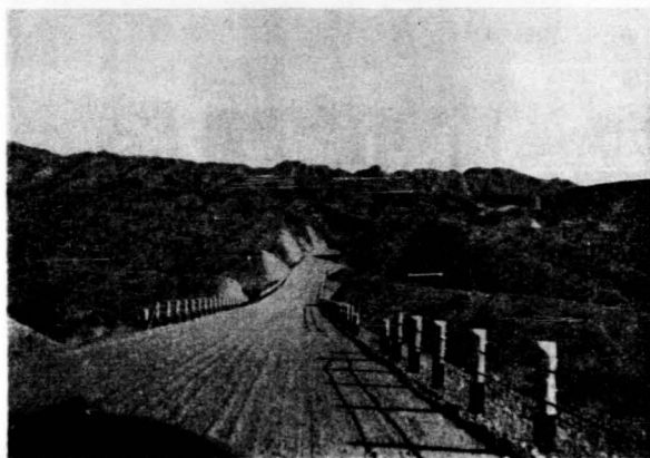
第十三圖 切土處方角改成圓角（路邊柵欄用木柱及鉛絲繩亦復簡省而堅固合用）
