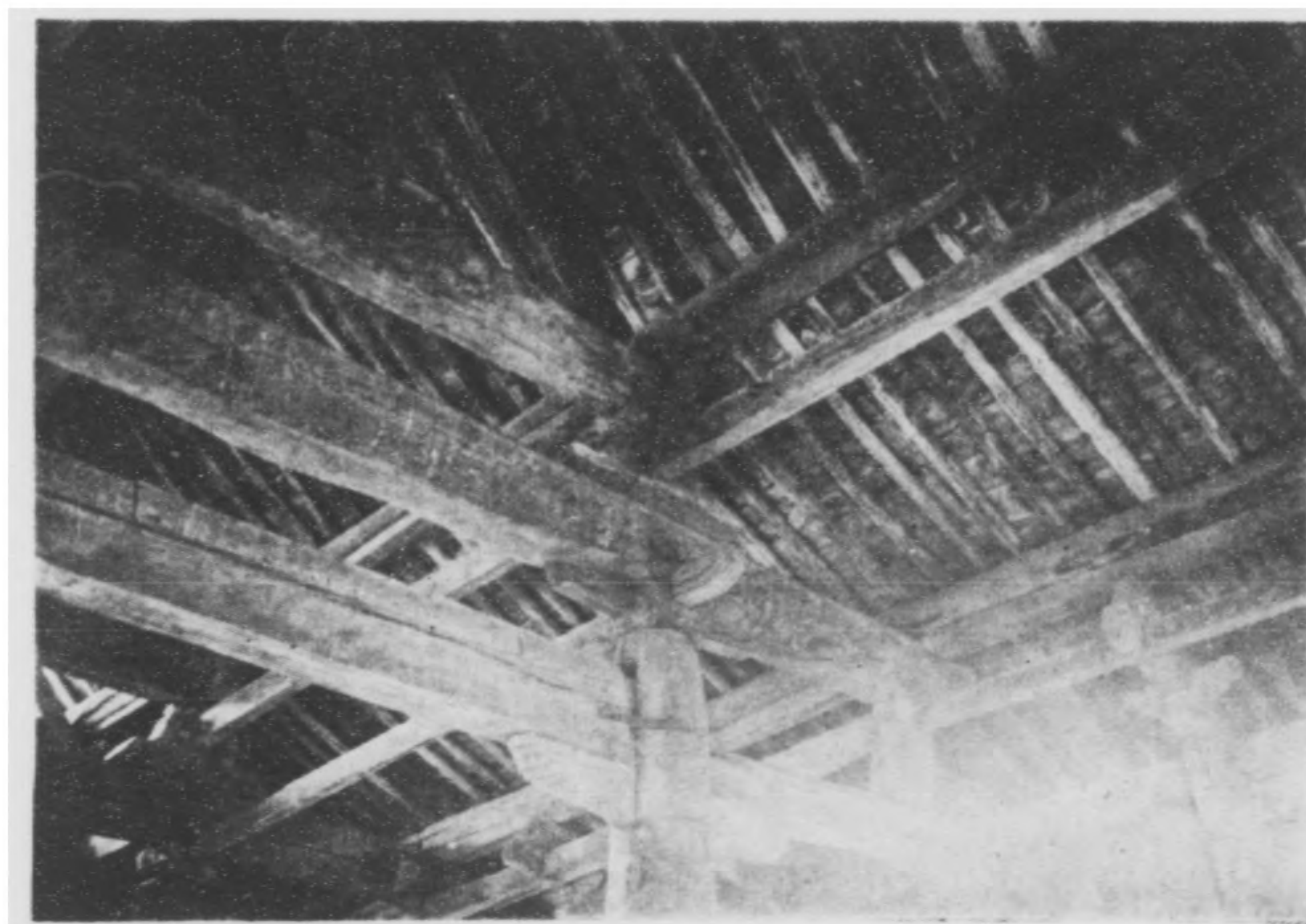
架梁間次樓和陽 圖一十六第
