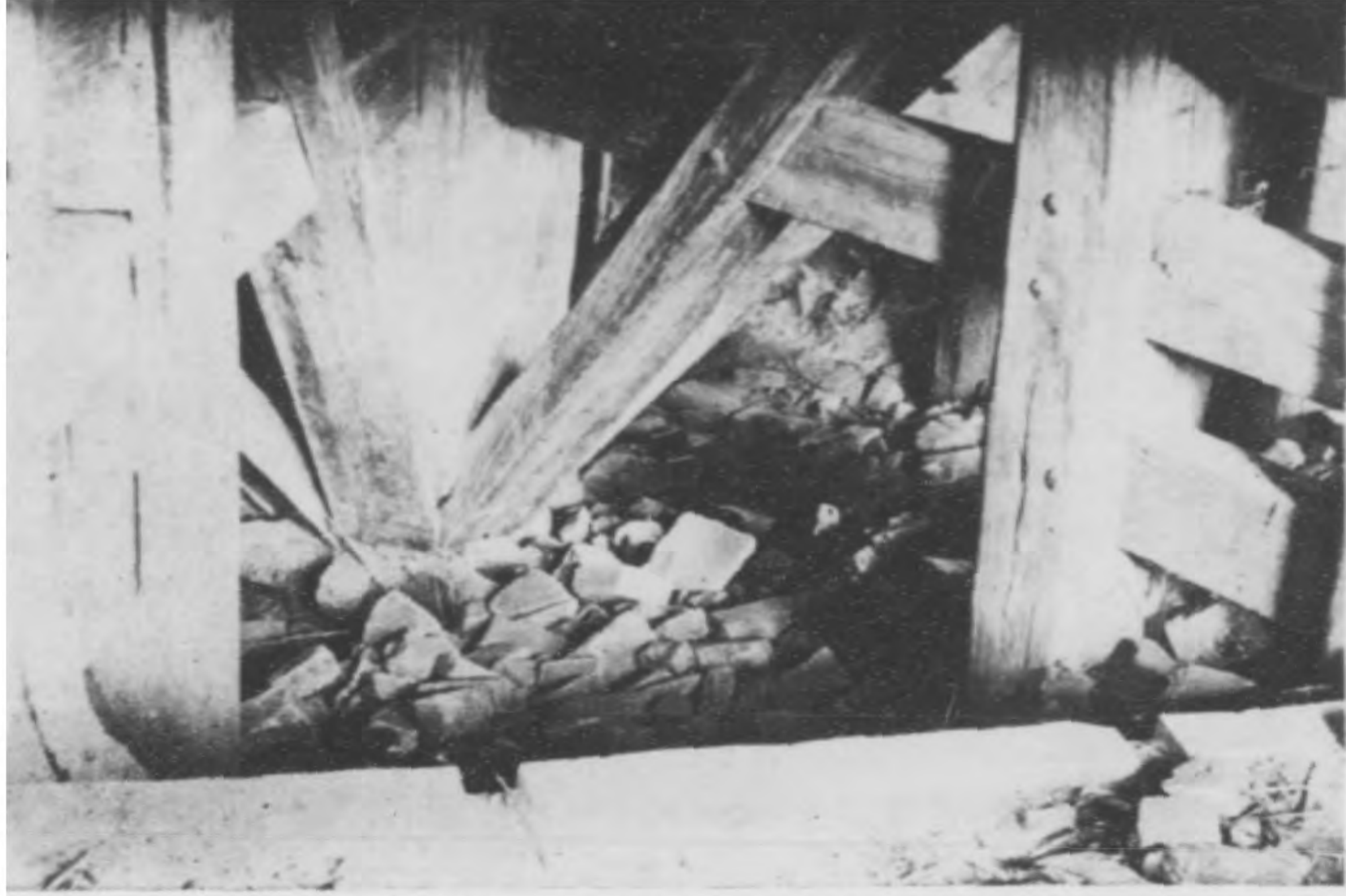
托軸軸轉藏輪轉殿藏輪轉寺興隆 圖八十二第
