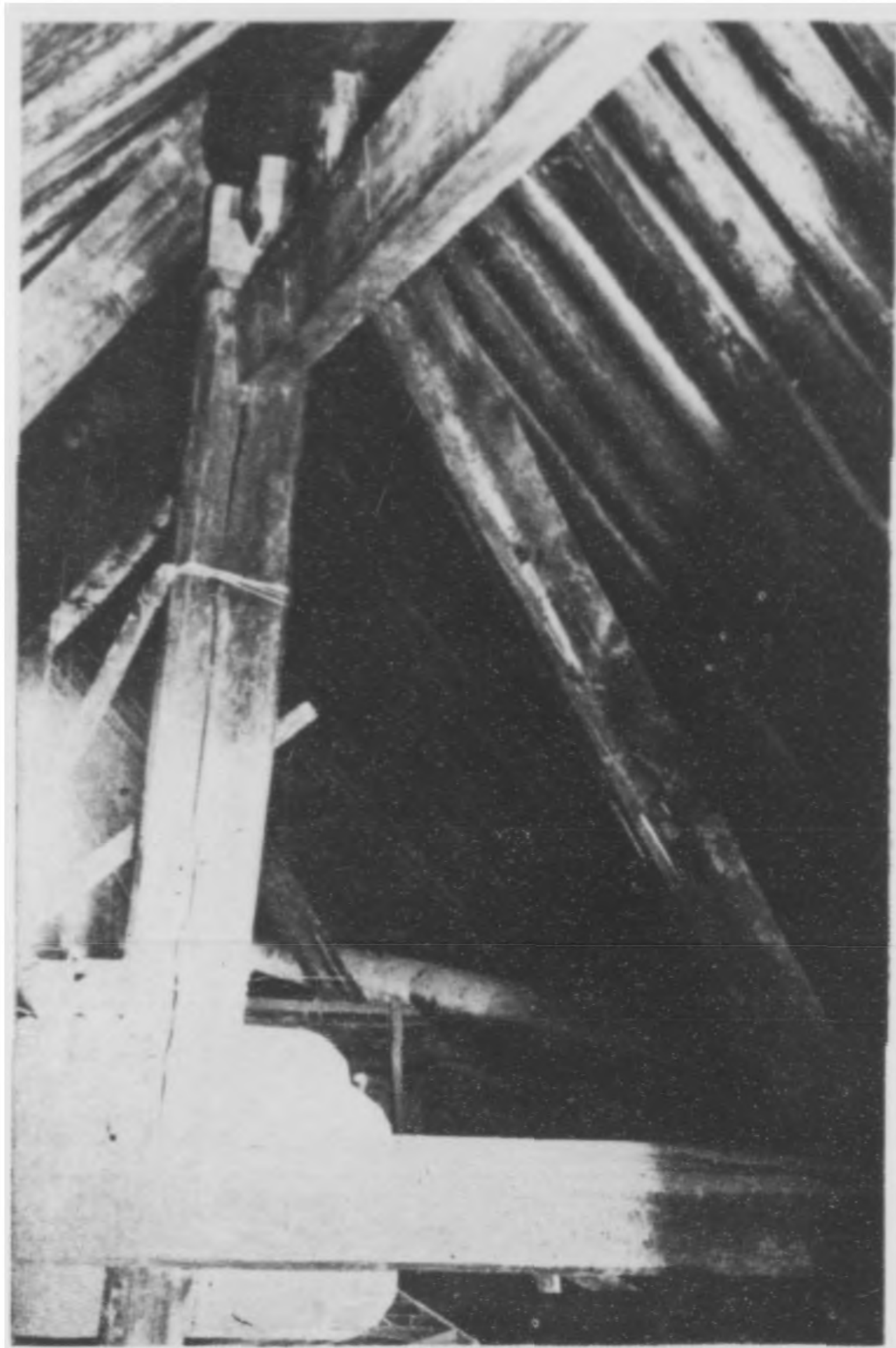
架構上梁平殿尼摩寺興隆 圖五第
