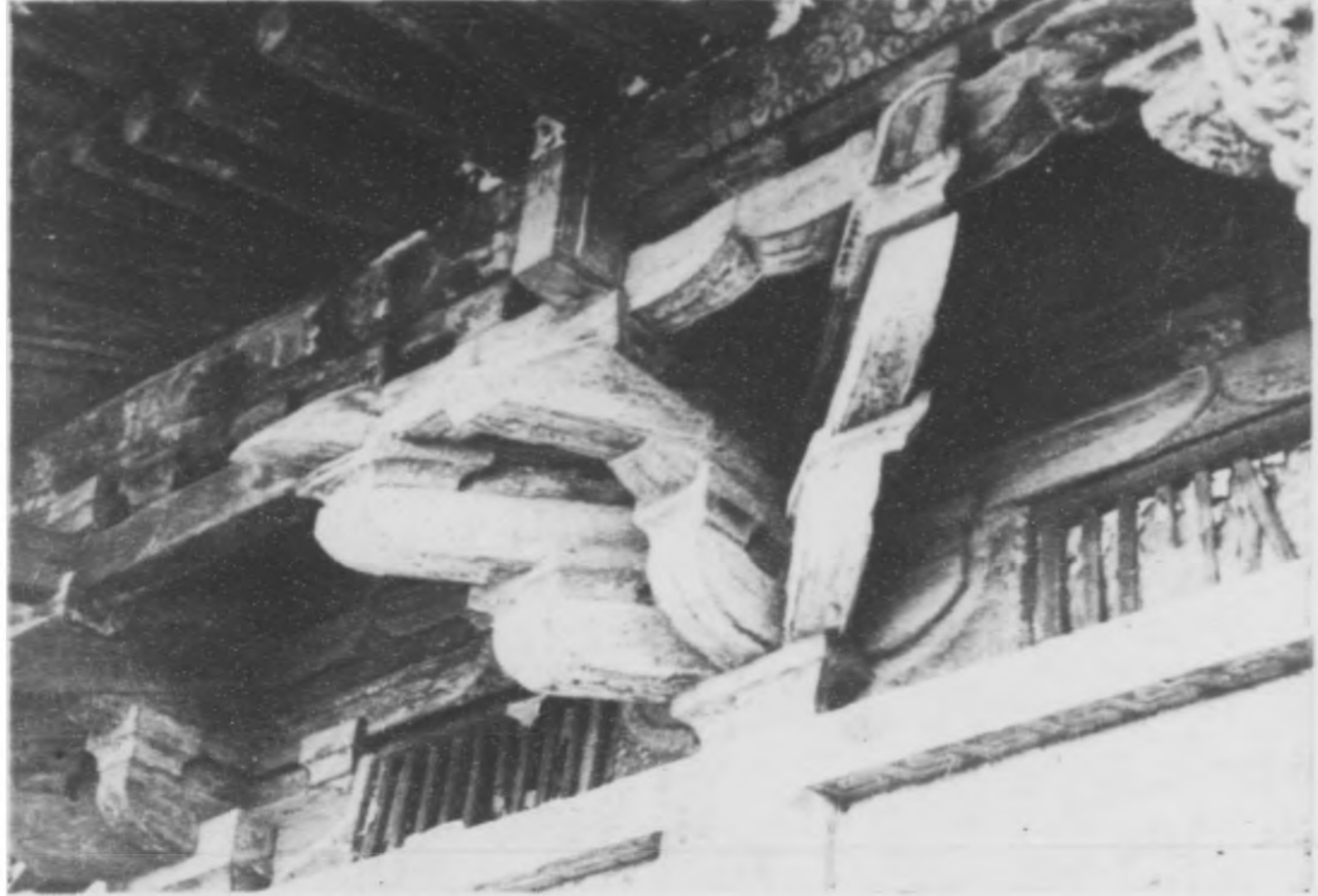
作鋪頭柱檐下廈抱面南殿尼摩寺興隆 圖九第
