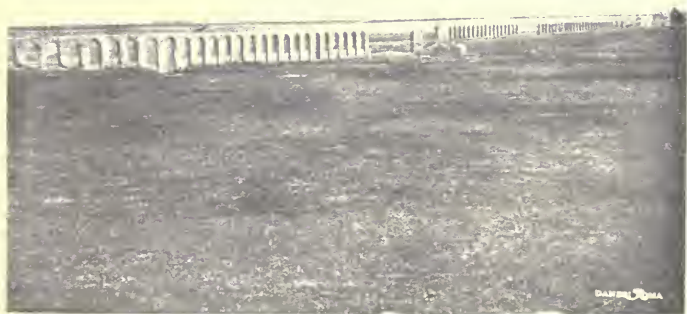
Acquedotto presso Tor di Mezza Via.
