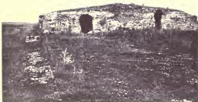
Conserva d'acqua della Villa dei Quintili.
