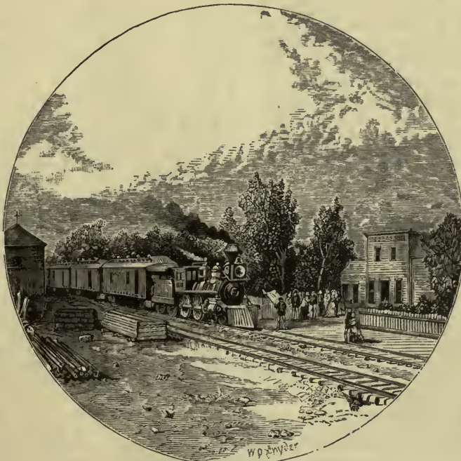
R. R. STATION, HUMBOLDT, NEVADA.
