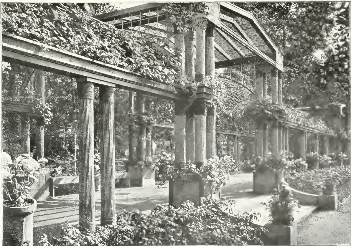
7. Pergola von außen gesehen.
