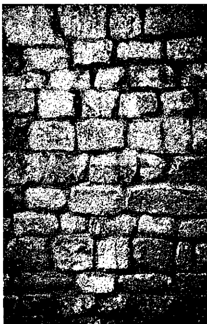
Aparejo interior de la Torre Muro del primer cuerpo, sin contar el bajo
