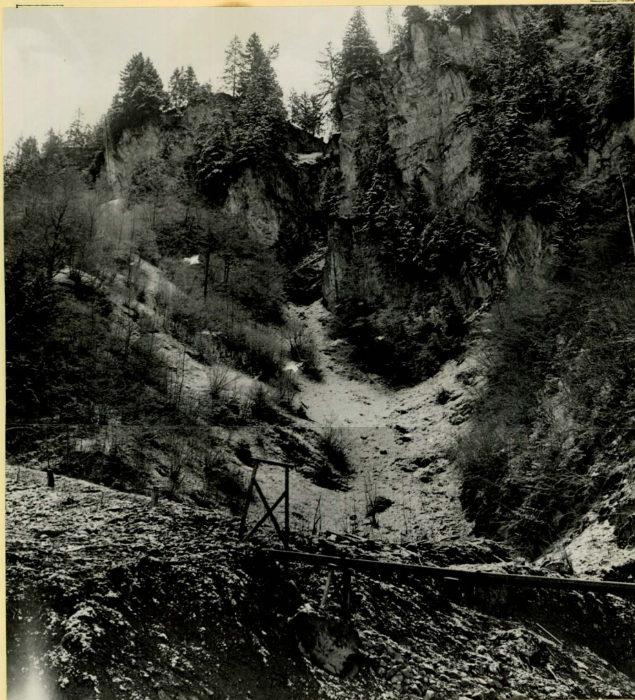
Photo 24. Die Schlüechtiskehle mit dem Aquädukt des Bruchgrabenbächleins über die eingestürzte Galerie. Phot. Beck
