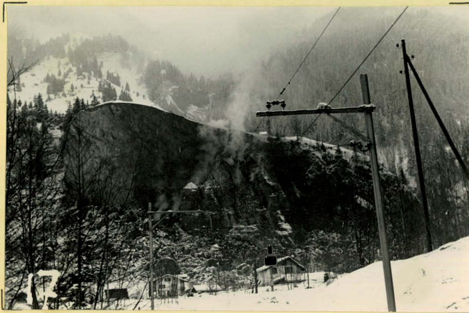
Photo 12. Rauchende Auswurftrichter am 21.12.1947. aus Kammern III - VI und Maschinenraum.
