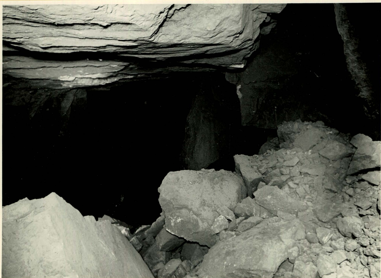
Photo 123: Felslamellen und Durchgänge 5m über dem Gewölbescheitel des Bahnstollens Richtung Nord vor Kammer VI. Der Boden bildet eine höhere Etage!
