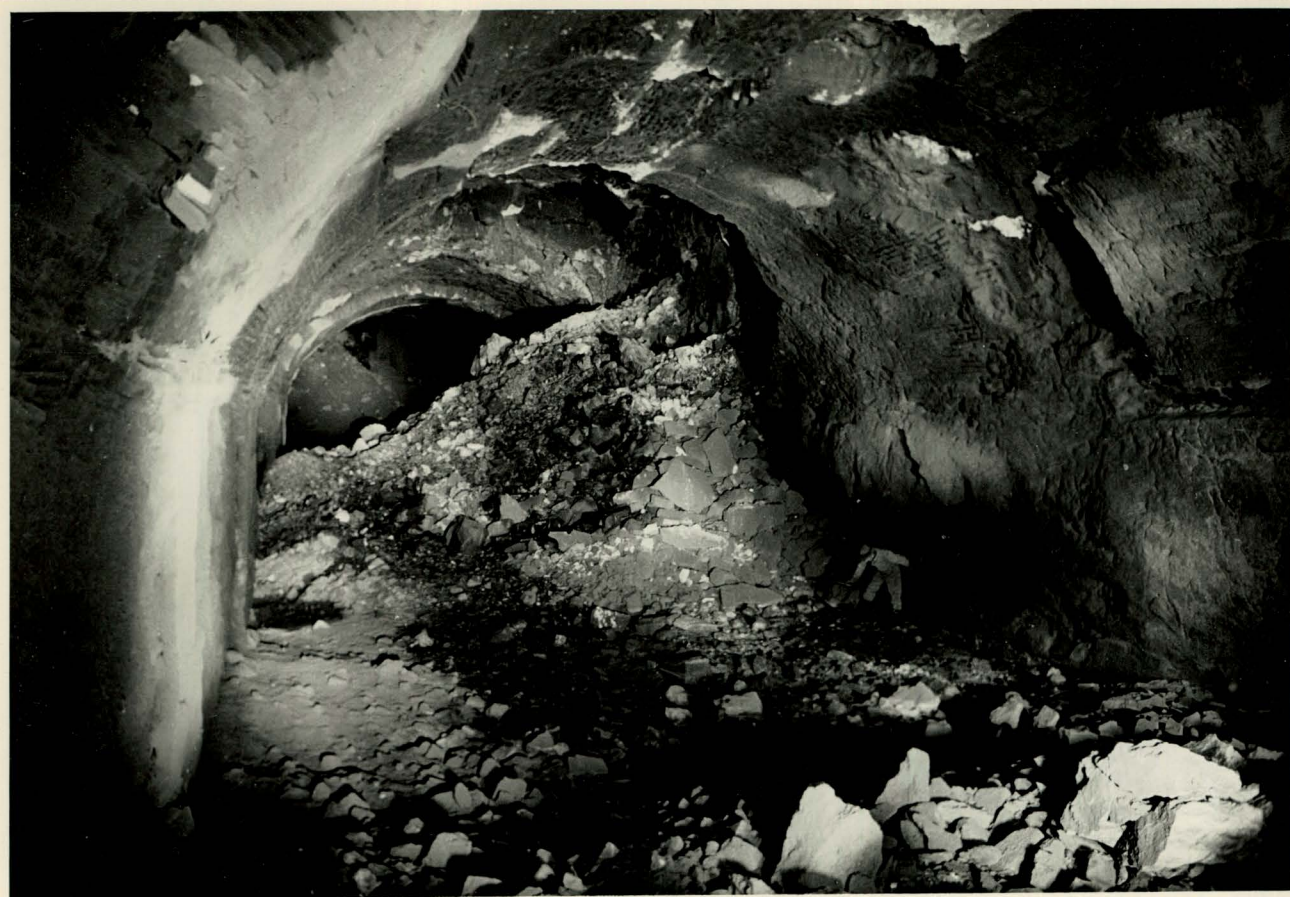
Photo 56 : Kammer III. Einbruch von Kluftschutt auf der Nordseite.
