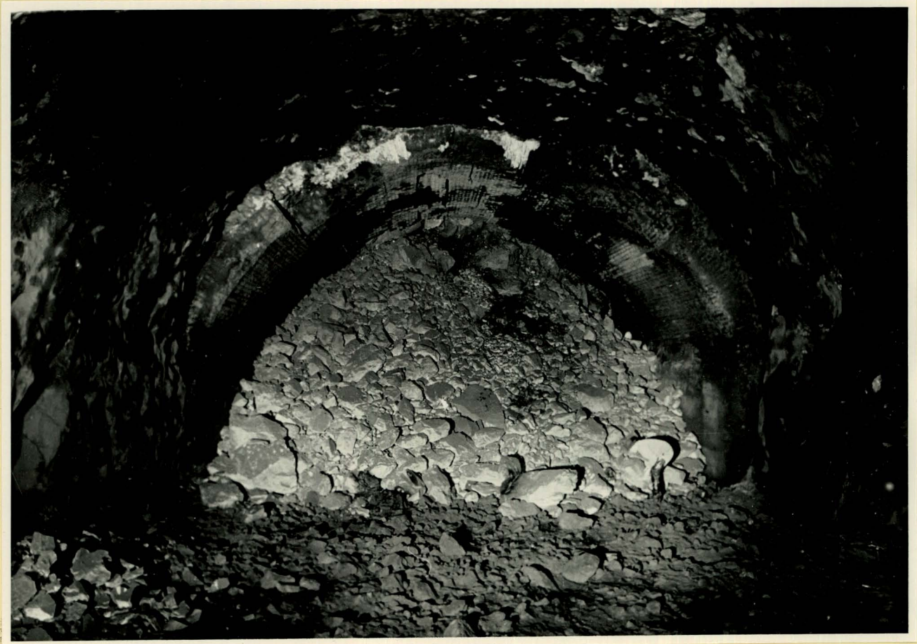
Photo 44 : Vollständiger Abschluss der Kammer II. Das Material stammt aus den grossen Ablösungsklüften in der Vorkammer. Die Gerölle sind nur "ausgerüttelt" worden, nicht durch die Explosion zersprengt. Die starke Ausmauerung ist bis an die Klüfte intakt, ca. 7.5m weit. Spricht gegen Grossexplosion in der Kammer II.
