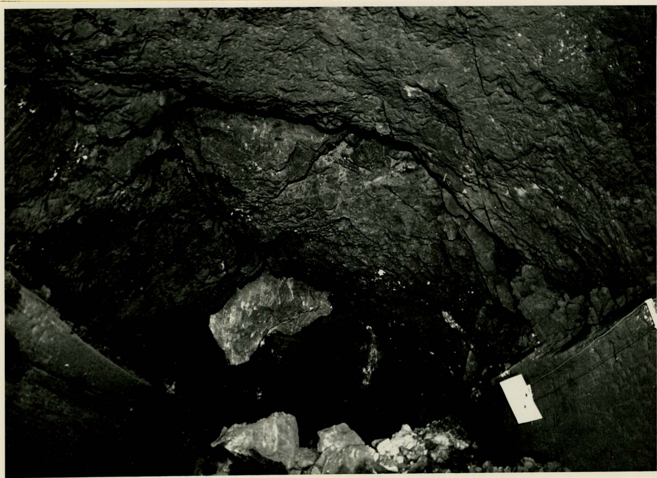
Photo 109 : Blick aus Kammer VI gegen den Bahnstollen. Die Widerlager auf beiden Seiten intakt. Dagegen der Bahnstollen durch Felslamellen teilweise ausgefüllt. Durchstieg nach Kammer IV und nach dem Auswurftrichter 7 möglich. Siehe Photos 22 und 23 !
