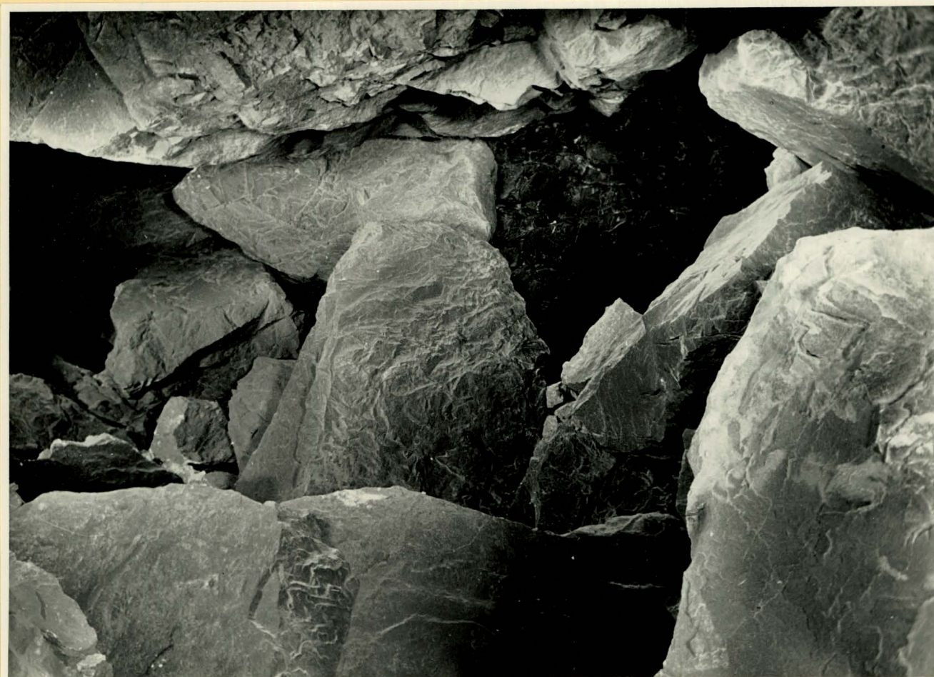
Photo 137 : Blick vom Versturz des Maschinenstollens senkrecht hinauf in die Lamellen und Zwischenräume des Bahnstollens .
