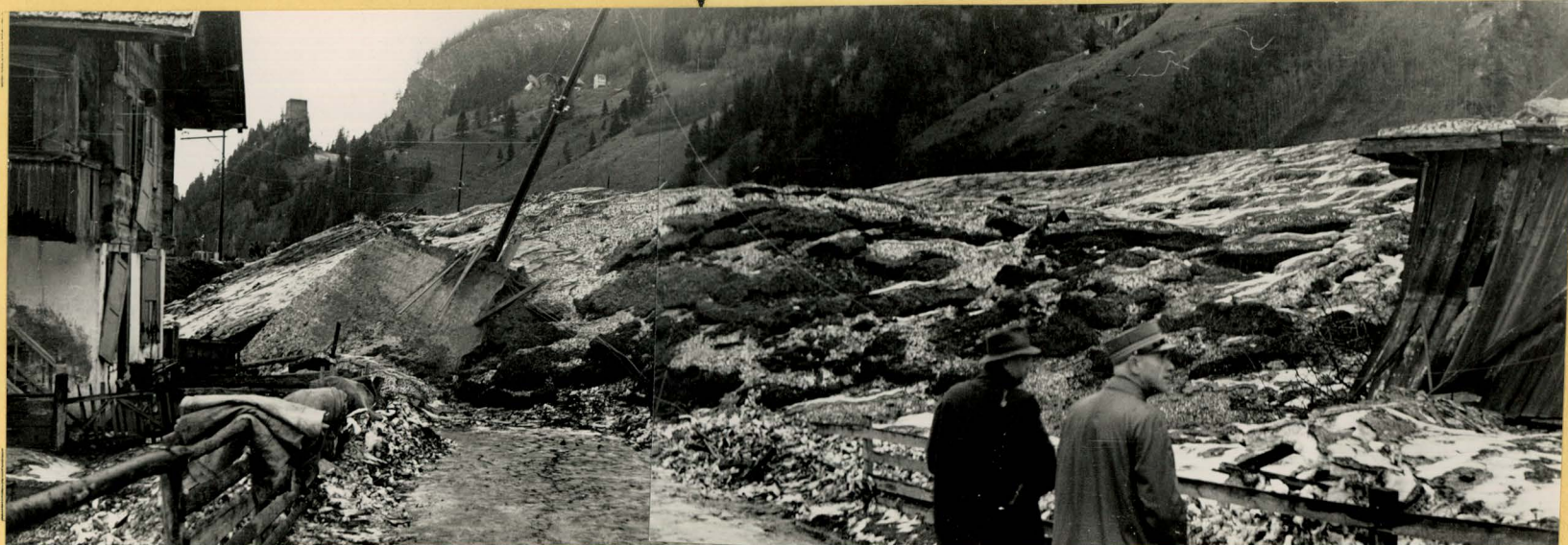
Photo 31. Verdrängung der Deponie durch den grossen Felssturz Der Strassenbelag ist gehoben (1) Stirnwellen 2 und 3.
