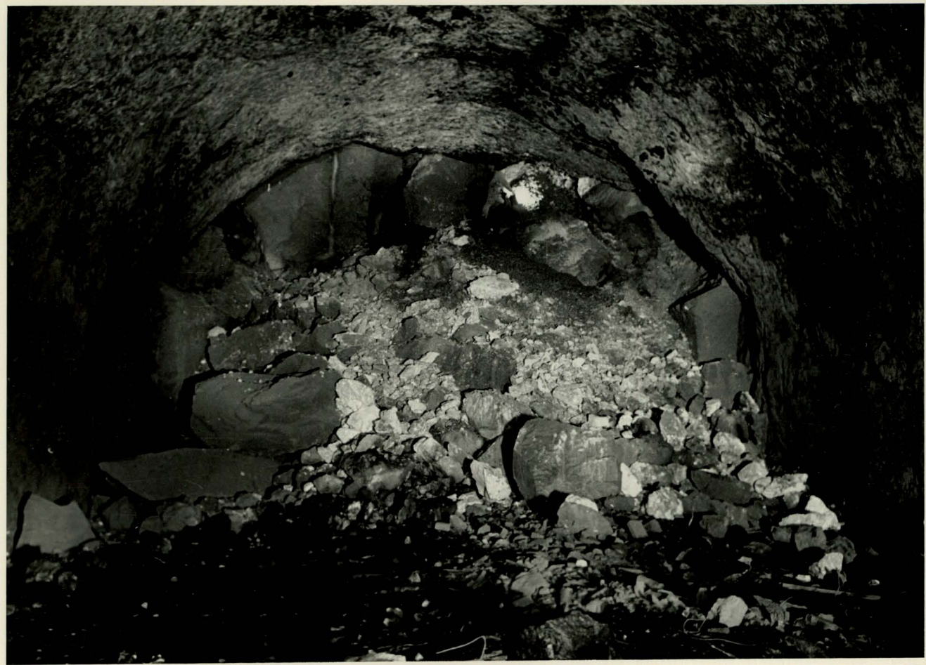
Photo 89 : Der Versturz der Kammer V gegen den Bahnstollen. Im Vordergrund Kluftschutt, im Hintergrund eingesackte Felslamellen des Bahnstollens. Nicht begehbar .
