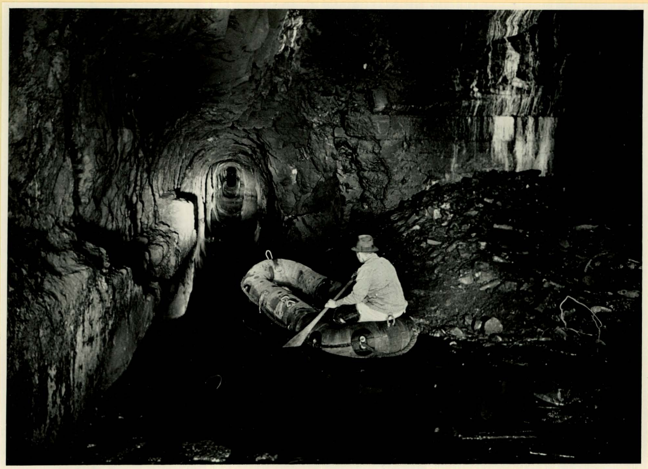
Photo 27: Der bezüglich der Felsen intakte hintere Verbindungsgang . Von Kammer I aus gesehen. Die Kante rechts ist weggeschlagen, die Abschluss- mauer total verschwunden.
