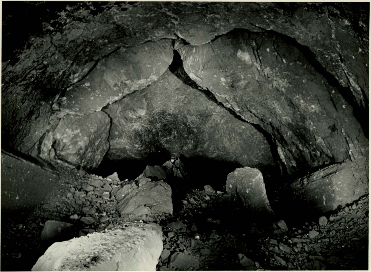
Photo 67 : Versturz der Kammer IV gegen den Bahnstollen. Im Vordergrund Kluftschutt, im Hintergrund riesige Felslamellen, die durch die Verschiebung der Aussenwand nach aussen einsacken konnten. Der Durchgang ist begehbar.
