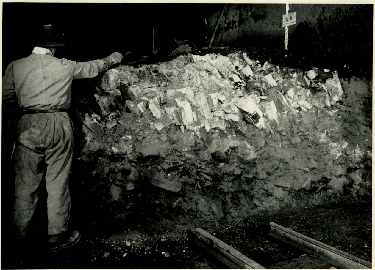
Photo 37c : Schuttmasse an der Nordwand K.I nahe der Entstehungsstelle der Explosion. Nur 2 Schichten: Oben die Trümmer des 54 cm starken Gewölbes, unten der gleichmässig gemischte Explosionsschutt. Hier fehlt mehr als 0,50 m Schutt.
