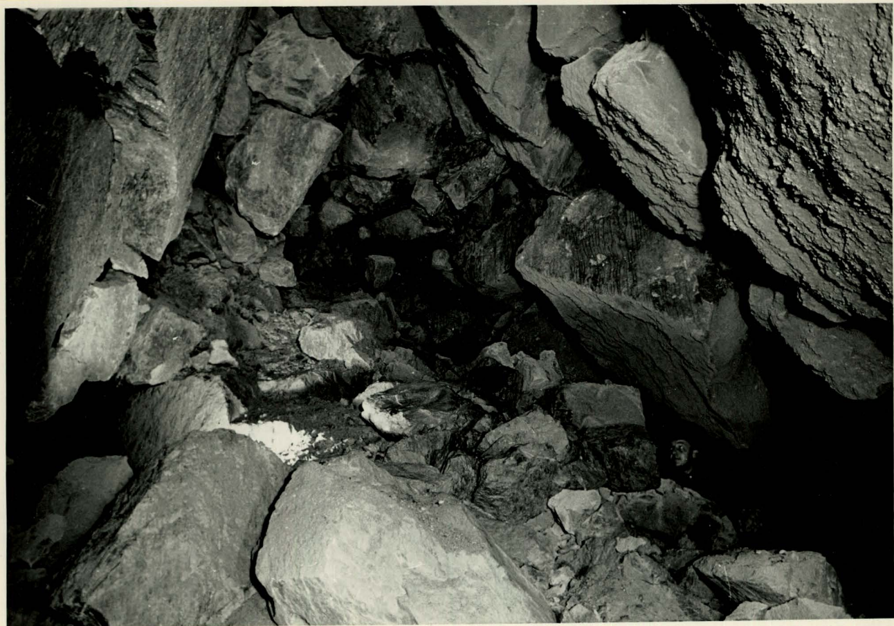
Photo 38 : Die grosse Diagonalkluft über dem Bahnstollen gegen K.I. Diese schwache Stelle befindet sich noch innerhalb der gebliebenen Felsmasse über dem Stollenscheitel. Riesige Kluftbrekzie .
