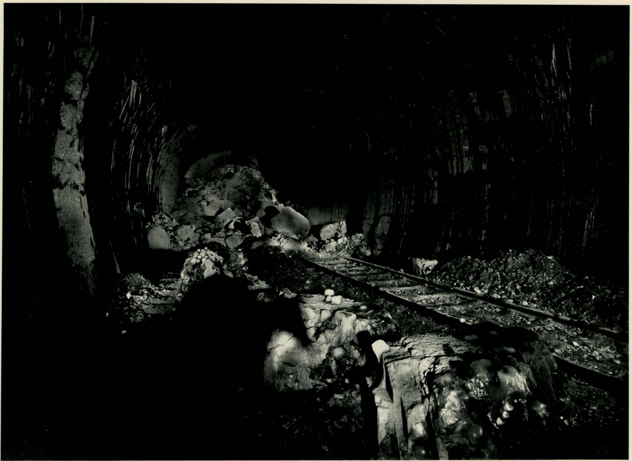
Photo 17 : Der intakte Bahnstollen in der Flyschpartie mit dem Versturz gegen den Verlastestollen. Im Vordergrund Kalkblöcke mit Eis, vor dem Versturz geschleudert.
