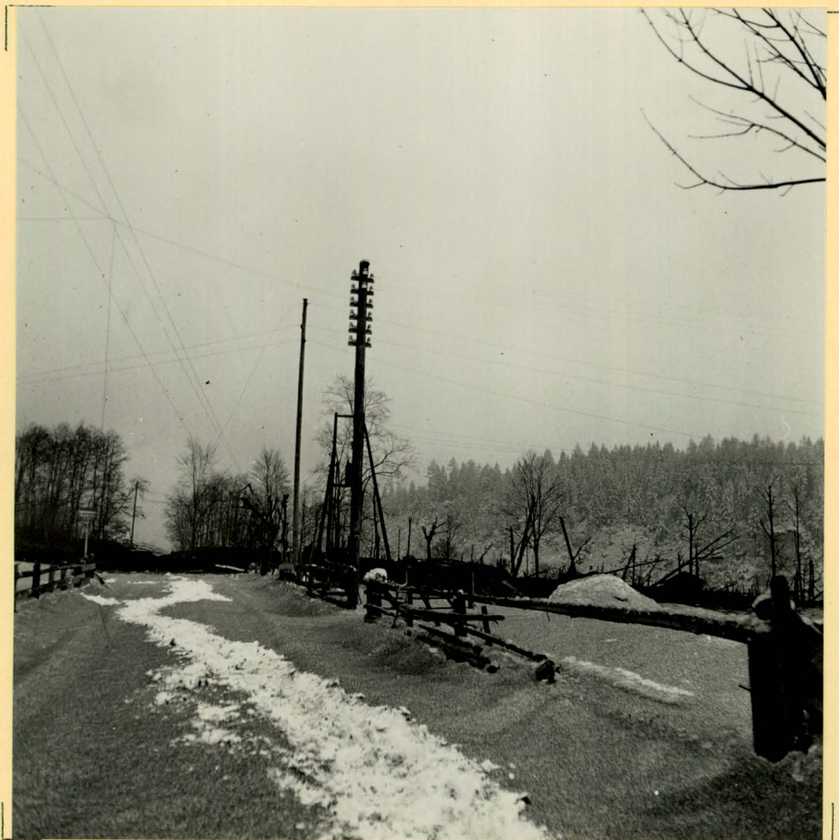
Photo 11 . Staatsstrasse unterhalb des Stegenbaches
