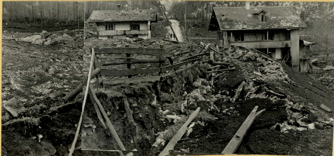
Photo 32. Die Stirnwellen der verdrängten Deponie und der gehobene Strassenbelag.
