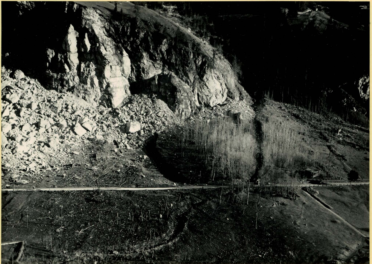
Photo 7. Kleine Ausbruchnische mit Trichter 7, Blockwurf, Materialstreuung und Schwärzung am 8.1.1948
