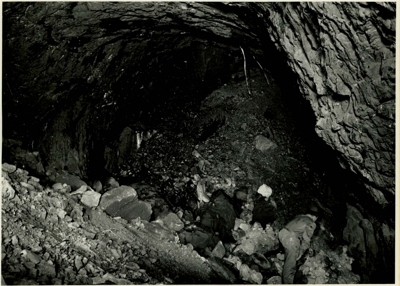
Photo 119 : Blick vom Bahnstollen in den Südzugang für Lastwagen. Das gunitierte Felsgewölbe blieb intakt. Die Verschüttung des Portals zeigt Bau- und Kluftschutt. Starke Durchschieferung des kompakten Felsens sichtbar.
