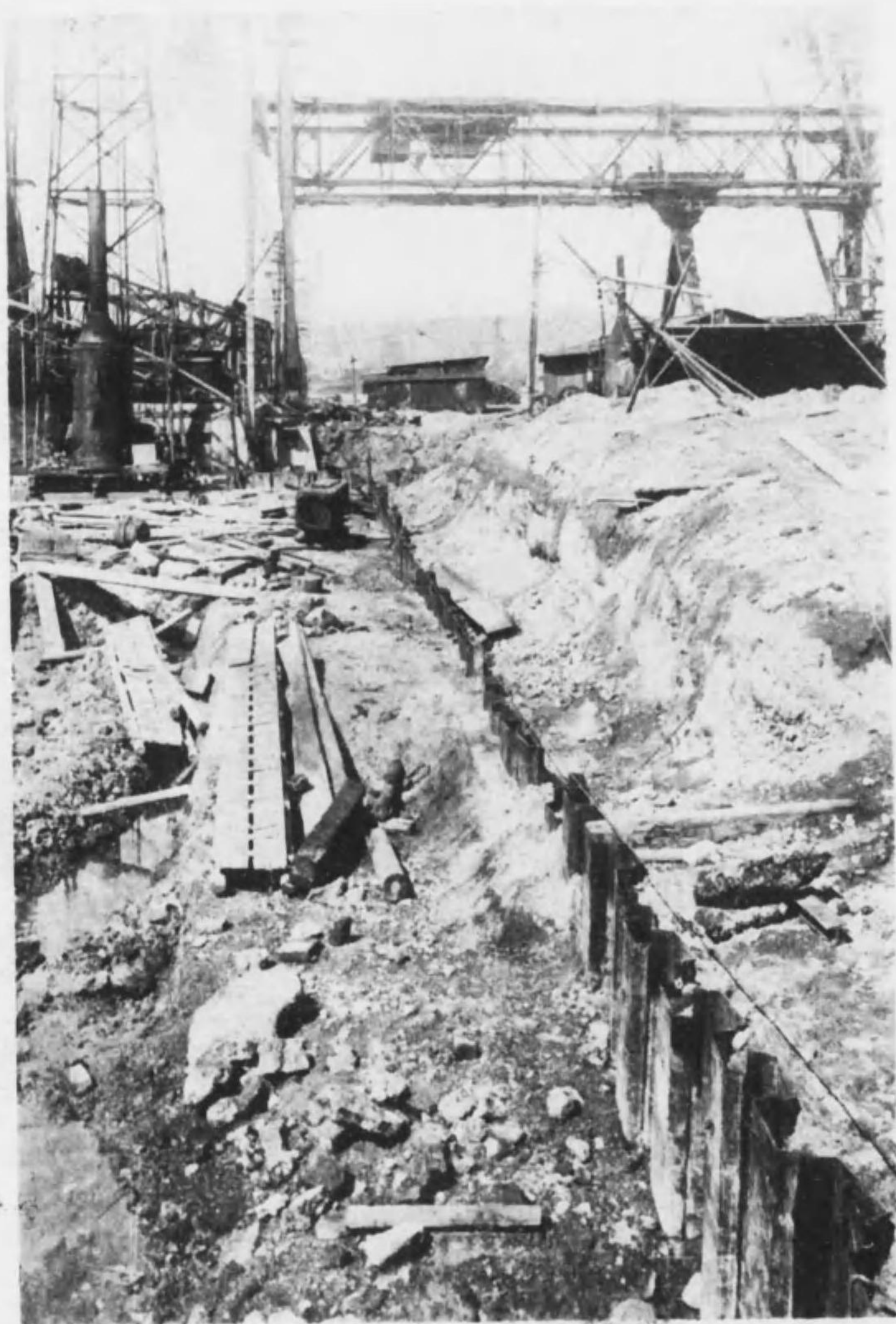
鋼矢板を使用したる状況
