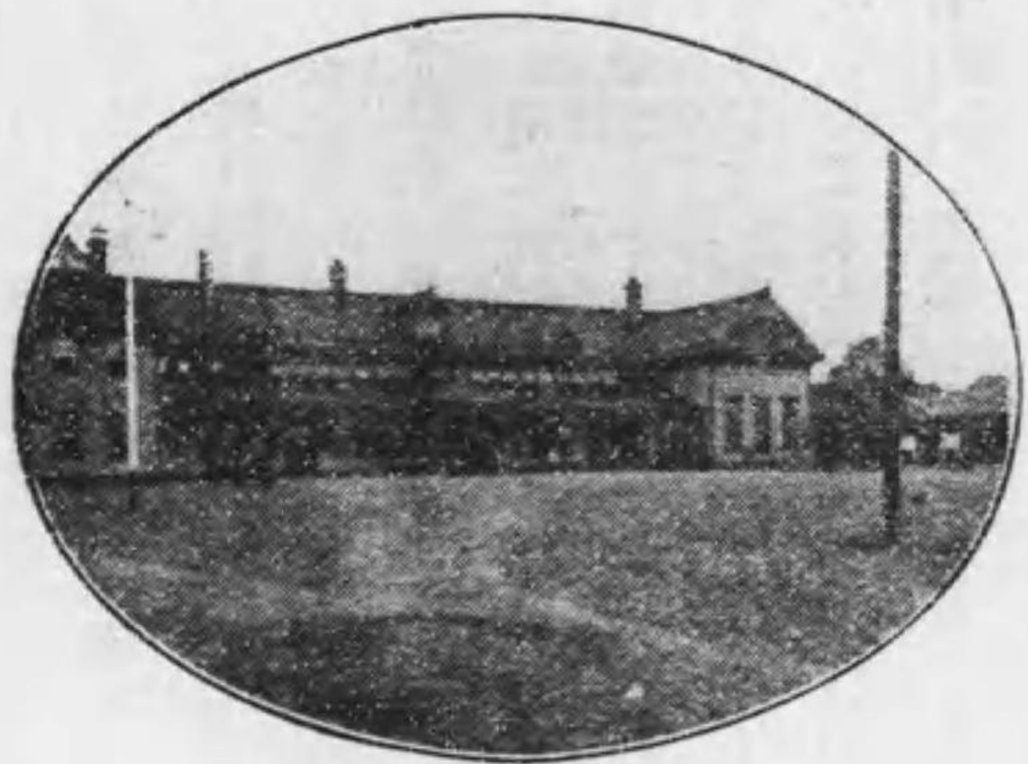
旭川附近に新設の木工場が多い。
