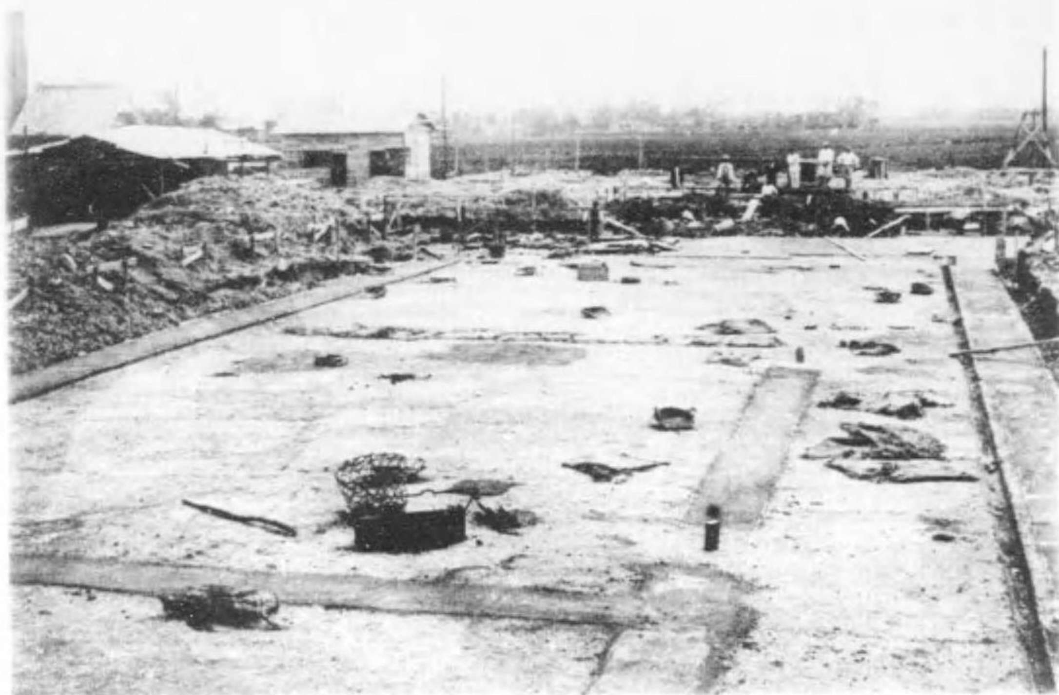
昭和十一年三月二十一日撮影。工事完了した基礎。地下土留置機が埋入した 場所。左が第一号土留置機
