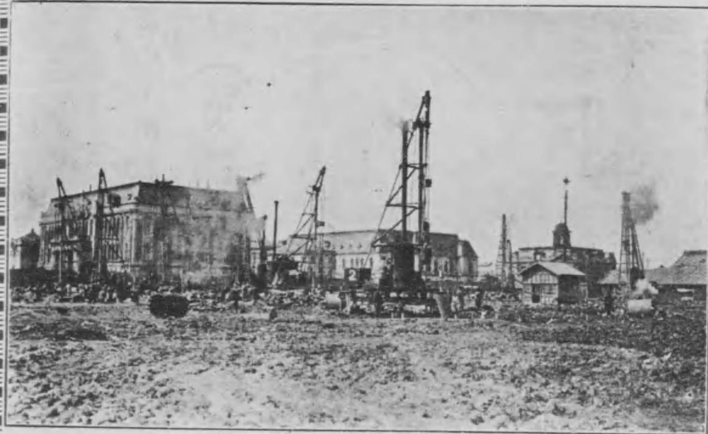
臺灣總督府新築廳舍コンプレツソル式基礎工事作業ノ實況
