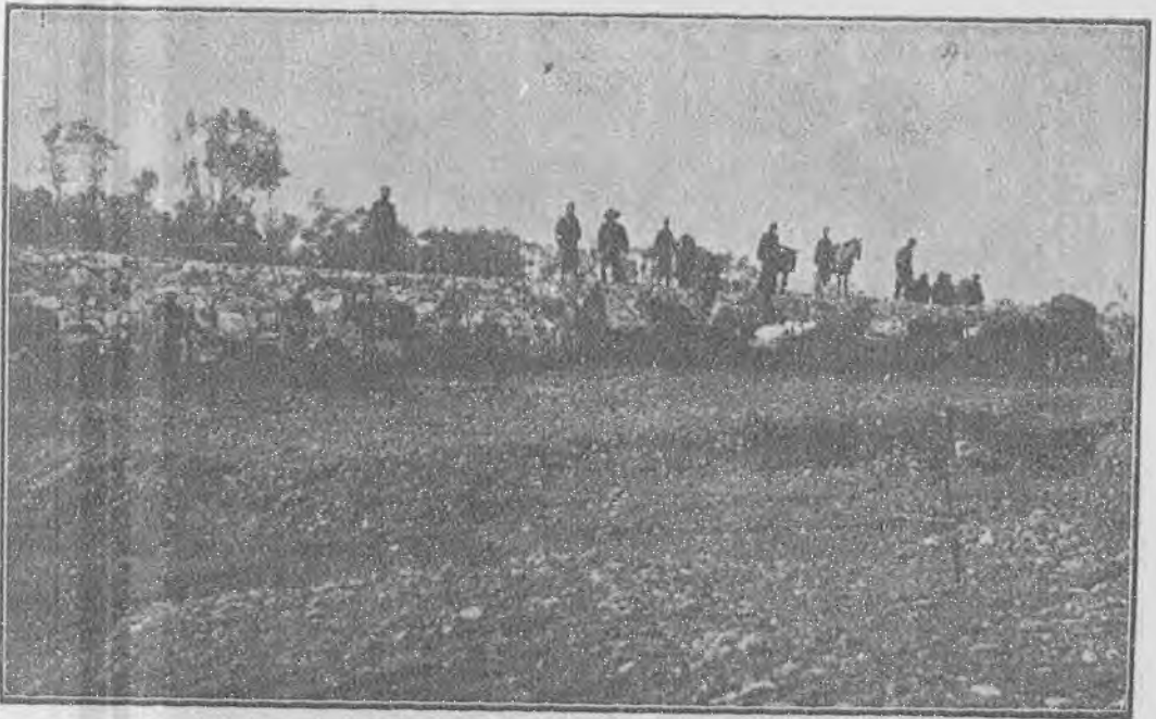
薩拉齊縣築水澗溝石壩工程完成
