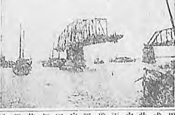
京義安奉鐵路鴨綠江橋梁
