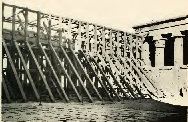
Charpente complète. — Façade intérieure.
