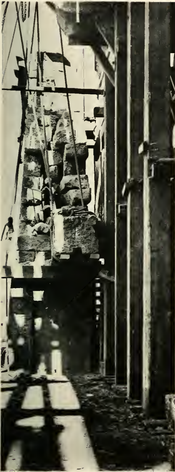
Démontage des blocs sur l'épaisseur du mur.
