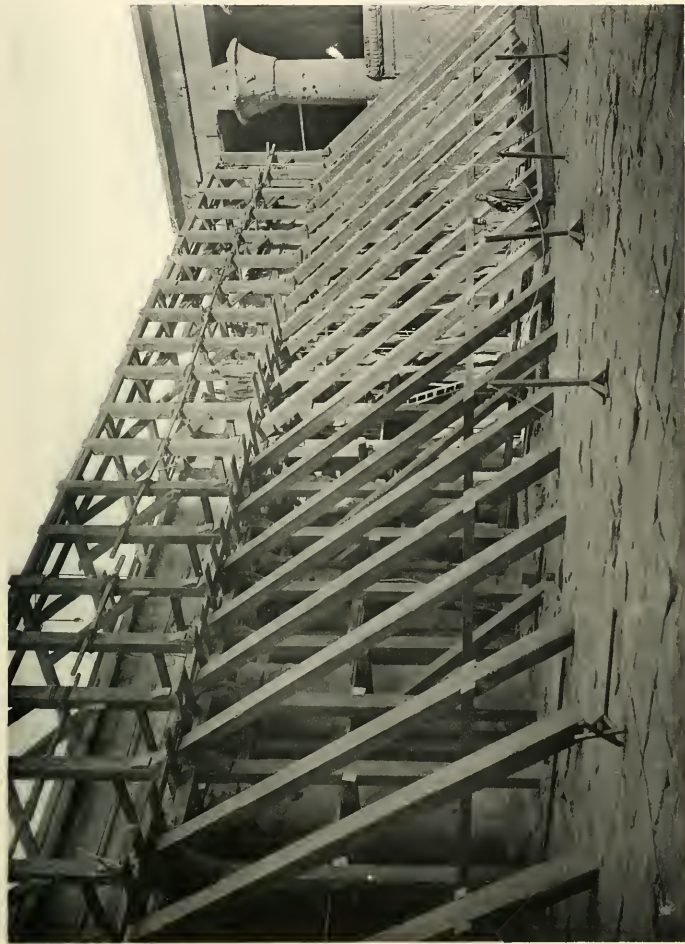
L'échafaudage achevé. — 30 janvier 1906.
