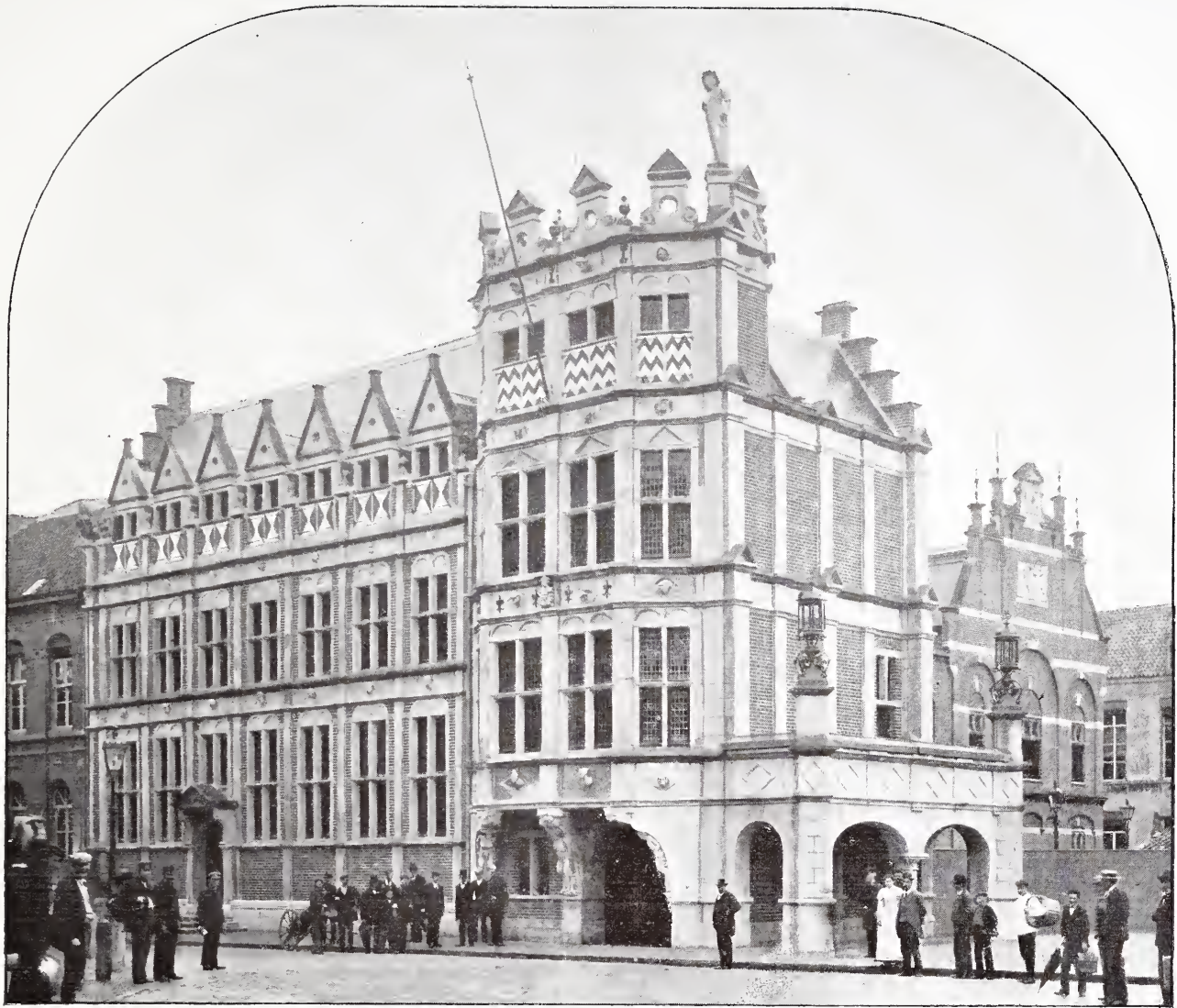
Gerestaureerde voorgevel en nieuw ontworpen zijgevel.
