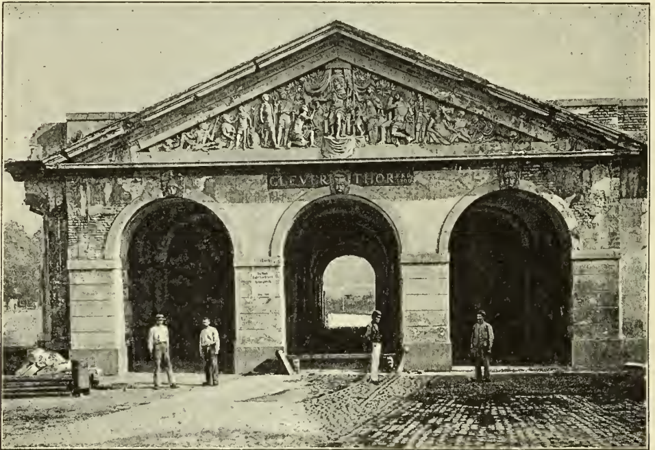
Fig. 73 Wesel. Ansicht des Klevertores.
