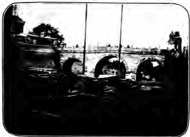
保定府天水橋
