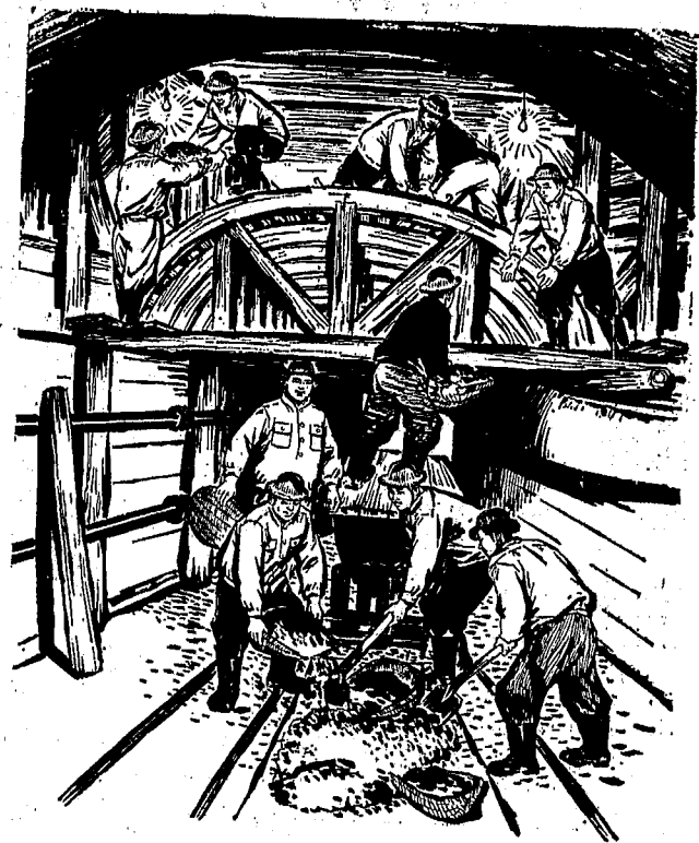
只争朝夕 ——紧张施工的运输巷道
