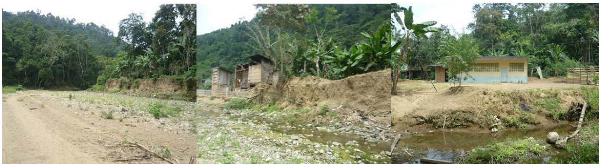
Sectores de la zona propensos a deslaves a causa de las crecientes del Río
