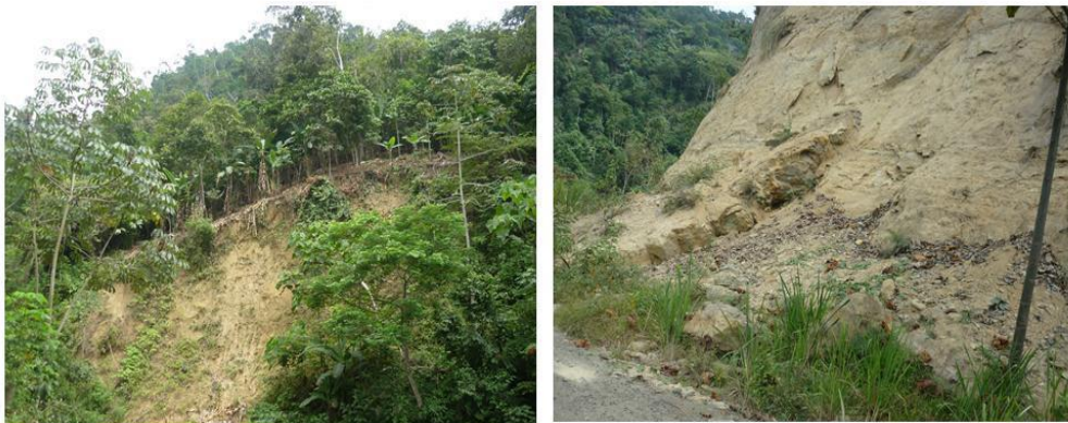
Sectores de deslaves localizados en la vía Noboa - Sucre
