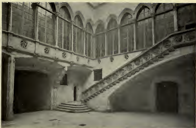
COURTYARD OF THE DIPUTACIÓN, BARCELONA.
