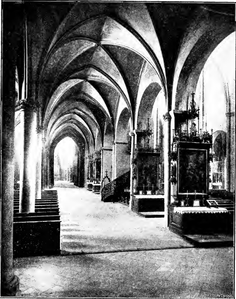
Abb. 3. Nördliches Seitenschiff des Domes.
