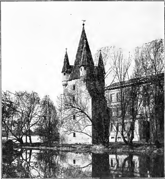
Abb. 18. Turm der Stadtbefestigung des 15. Jahrhundert.
