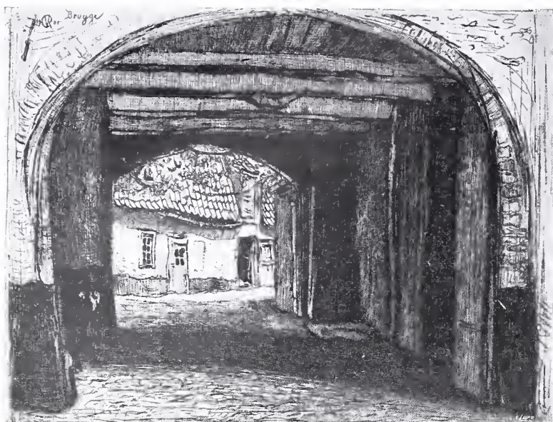
POORT TE BRUGGE.
