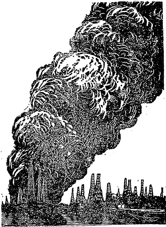
因爲油池保護不周常常造成火災
