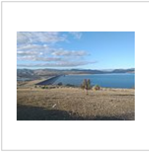
Barrage El Ouahda
