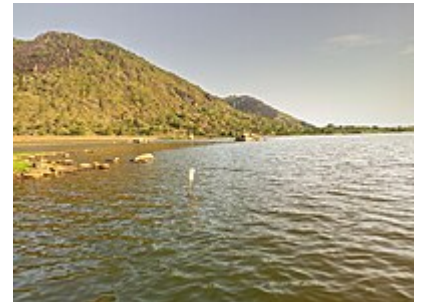
Le Barrage de Mokolo à Douvar
