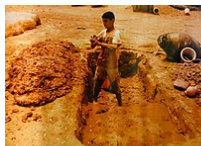
Extraction de l'argile de la fosse de délayage
