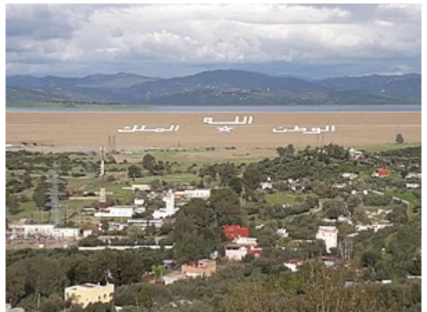
Vue sur le barrage d'Al-Wahda
