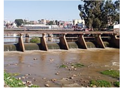
Barrage de Tanjombato
