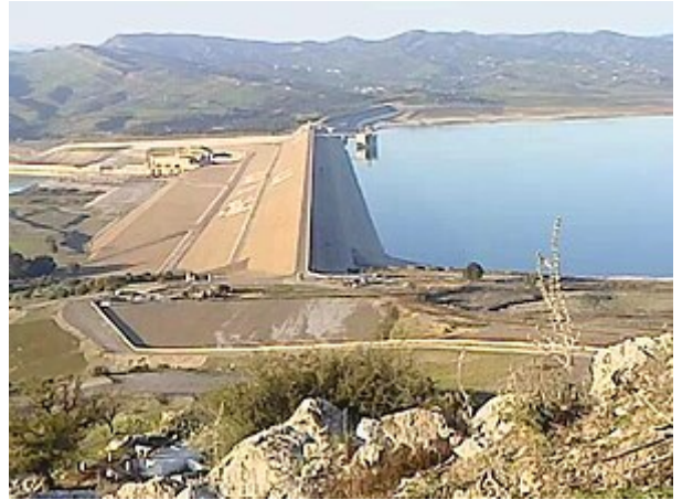
Vue sur le barrage d'Al-Wahda
