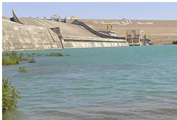
Vue sur le barrage d'Al-Wahda
