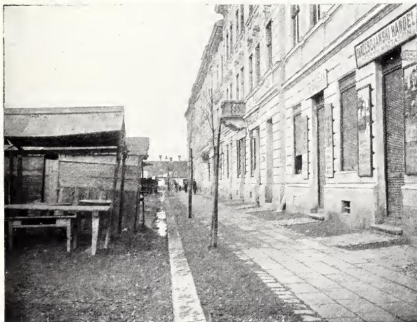
Zwei Aufnahmen von demselben Standpunkt. Beim unteren Bild war die Brennweite gleich der Plattenlänge (12 cm), beim oberen gleich der doppelten Plattenlänge (24 cm). Man beachte die dadurch bedingte Verschiedenheit des Bildwinkels, der Größenverhältnisse und der Perspektive.
