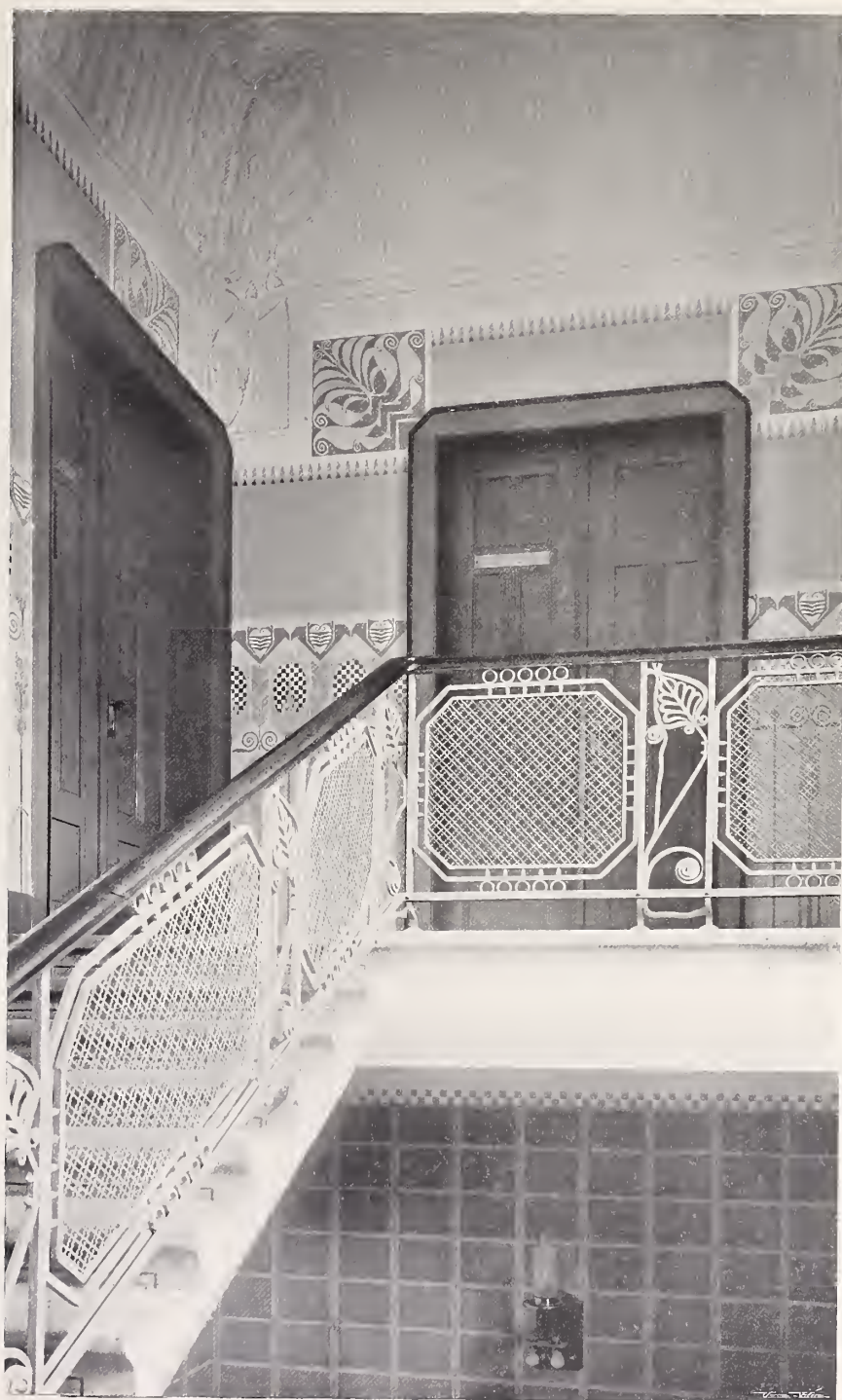
■ JAN KOTĚRA. ■ OKRESNÍ DŮM V HRADCI KRÁLOVÉ - SCHODIŠTĚ.
