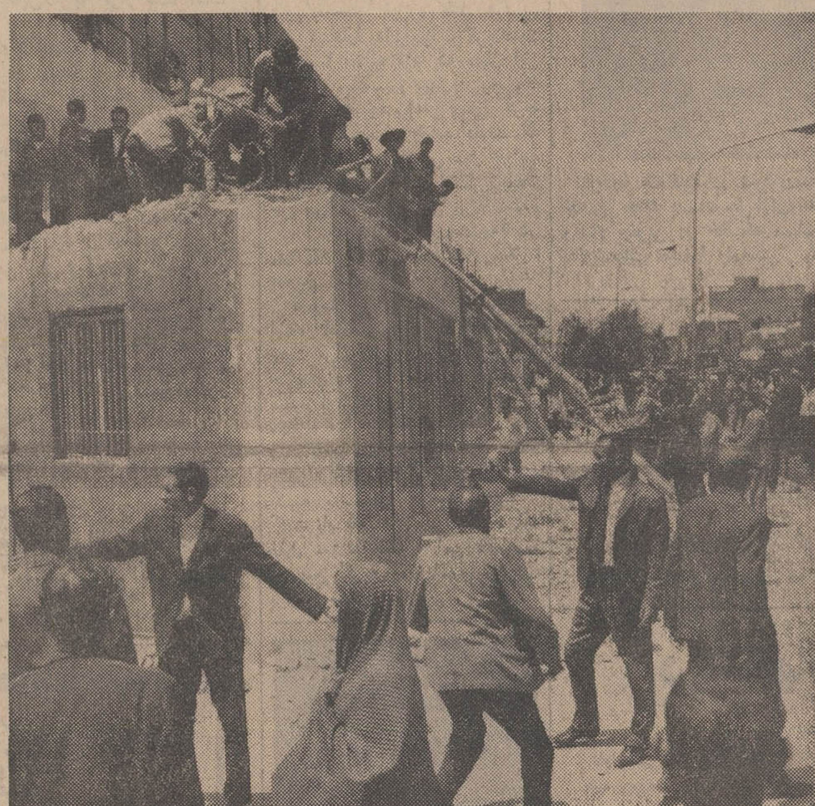
مأموران شهرداری در خیابان شاهرضا مشغول خراب کردن ساختمان بدون پروانه و متجاوز بحد خیابان میباشند
