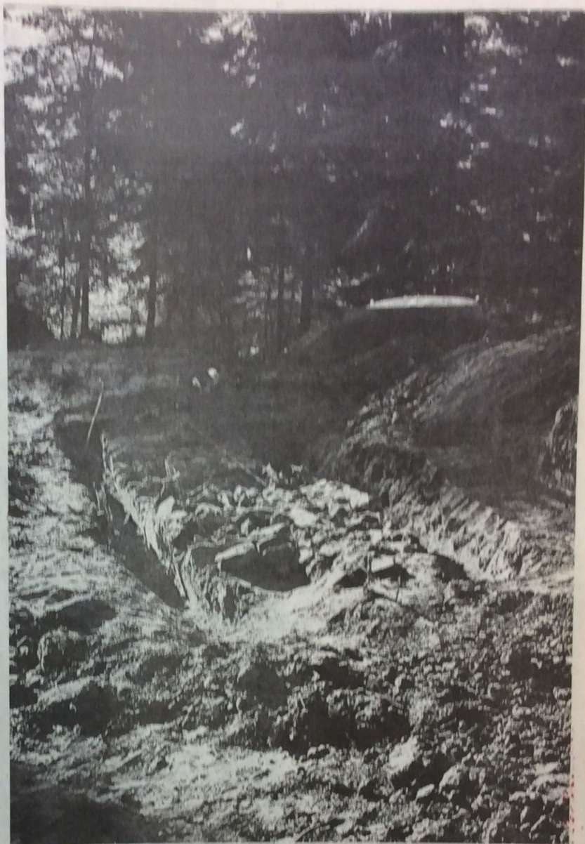
BEI GRABUNGEN 1972 freigelegtes Limesfundament im Wald Hintere Orthalde im Schießtal. (Foto: ZF)
