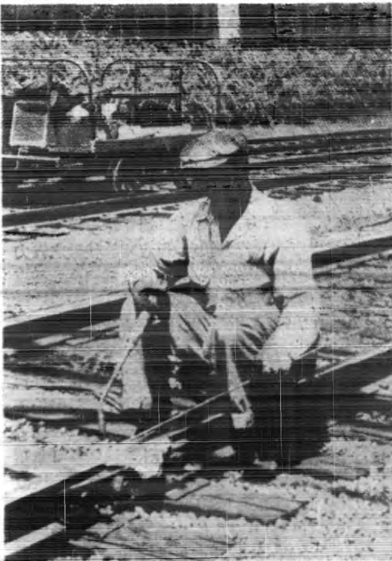
↓ 焊補軌條接頭增加行車安全及舒適
