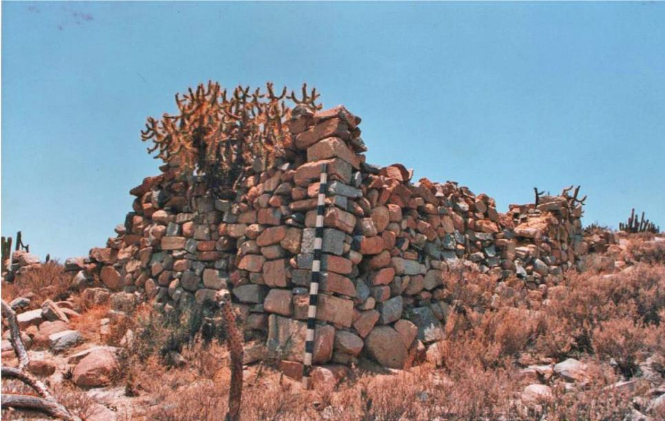
Fig. 8 Muro de mampostería ordinaria, con pilastra en esquina, ubicado en la estructura. n° 18
