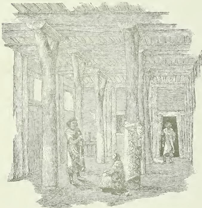
Fig. 677. — ESTRUCTURA DE UNA CASA ASIRIA DE MADERA, DEDUCIDA DE LAS ACTUALES CABAÑAS DE LOS YEZIDIS (SEGÚN VIOLET-LE-DUC Y LAYARD)
