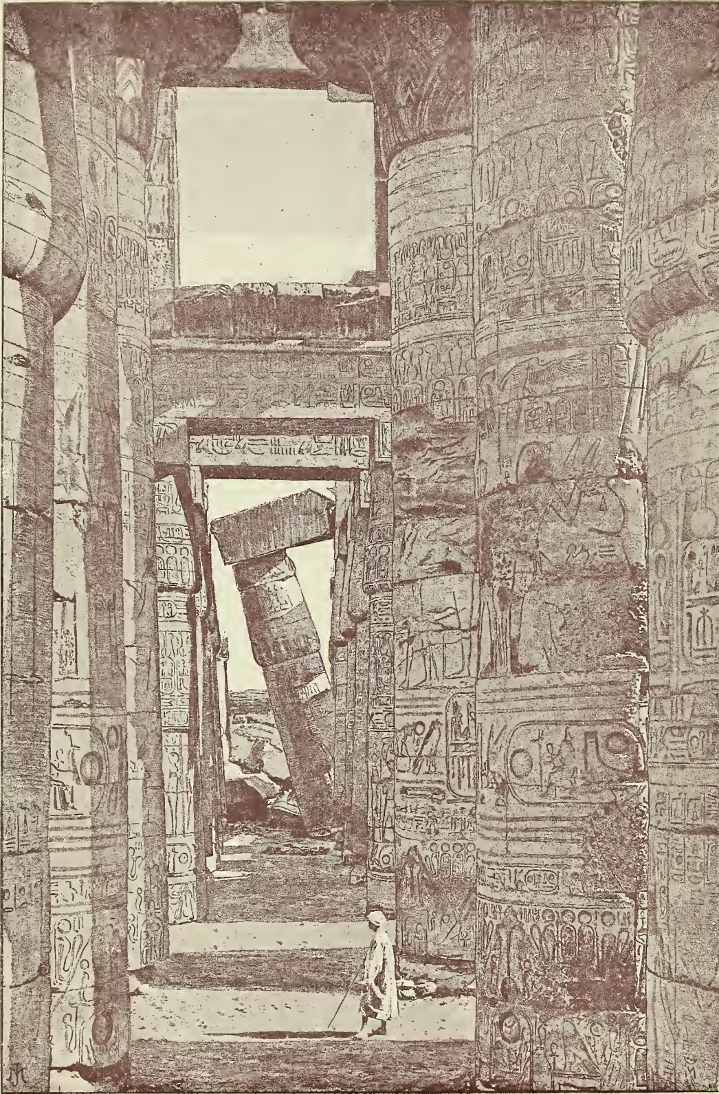
Fig. 513.—NAVE TRANSVERSAL DE LA GRAN SALA HIPÓSTILA DE KARNAK (ESTADO ACTUAL)
