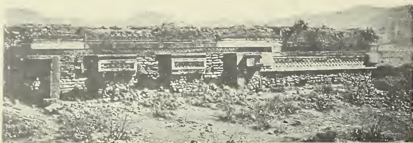
Fig. 912. - FACHADA OCCIDENTAL DEL CUARTO PALACIO EN MITLA
