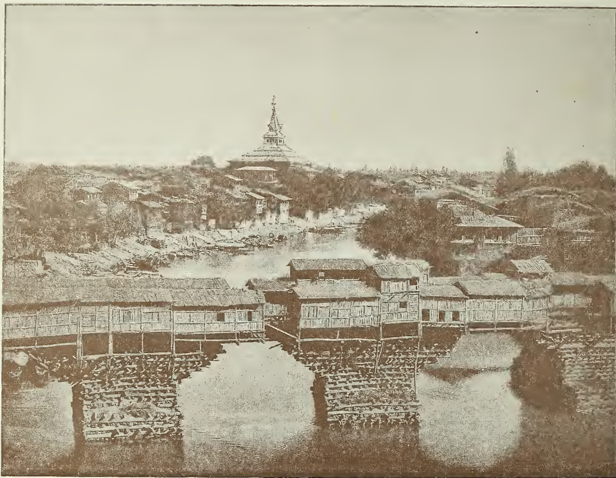
Fig. 158. — PUENTE DE RIMAS DE MADEROS, EN LA INDIA
