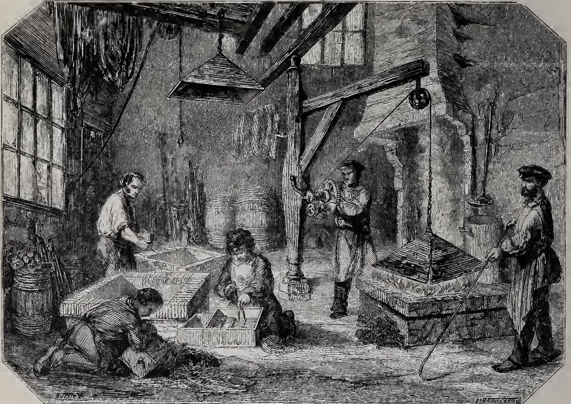
Fig. 7. Atelier de cémentation.—Transformation des aiguilles de fer en acier.
