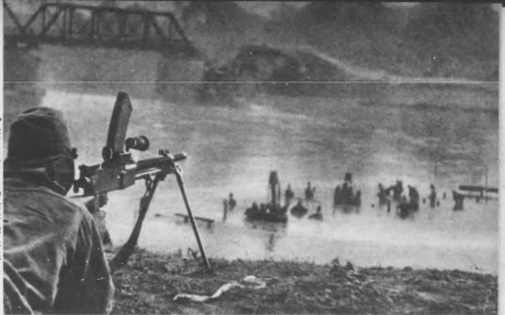
敵の打ち出してくる弾丸が近くまで水しぶきをあげる。機銃の掩護下、架橋を急ぐわが工兵隊
