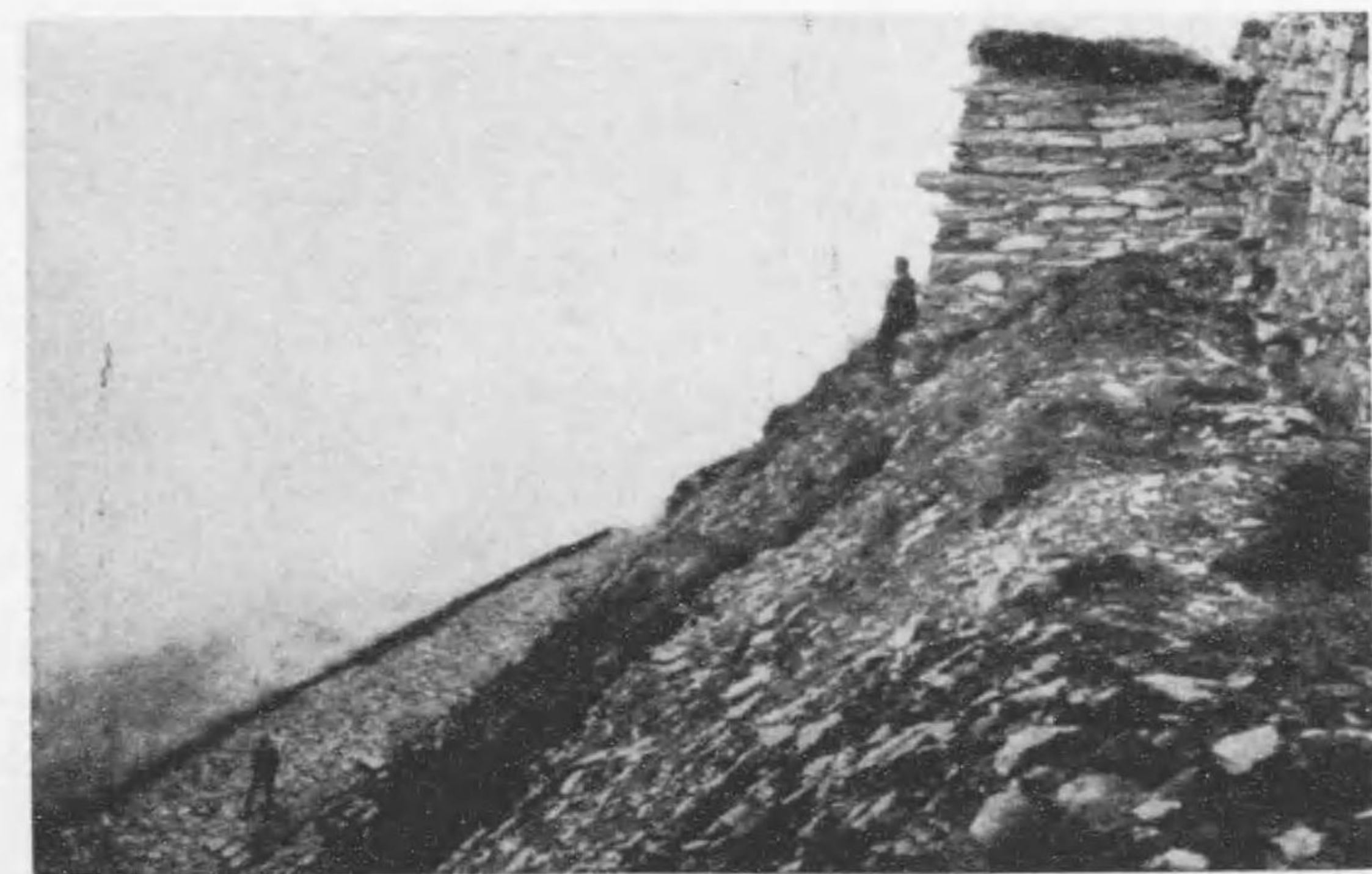
1 2 圖 「トレントアルプ」 最上部ノ雪崩發生地點ニ設置セラレタル擁壁
