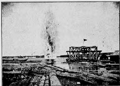
Взрывъ камня во время работъ по очисткѣ фарватера на рѣкѣ Днѣпрѣ, близъ г. Енатеринослава.
