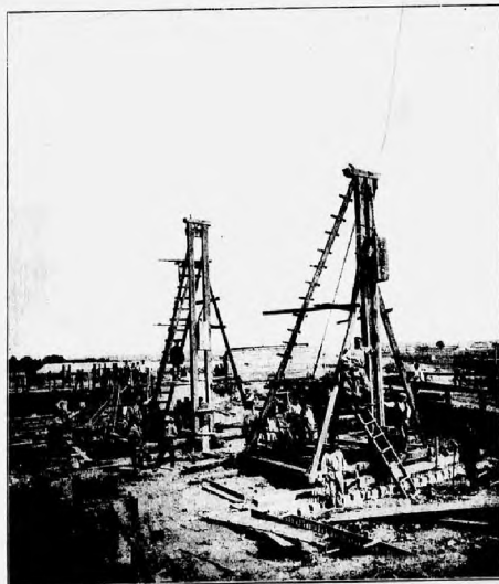
Забивка желѣзо-бетонныхъ свай по системѣ Геннѣвикъ при постройкѣ моста въ Тритузныхъ хуторахъ Екатеринбургской губерніи и уѣзда; строители инженеры Монкиуръ и Эггеръ въ Екатеринбургѣ.
