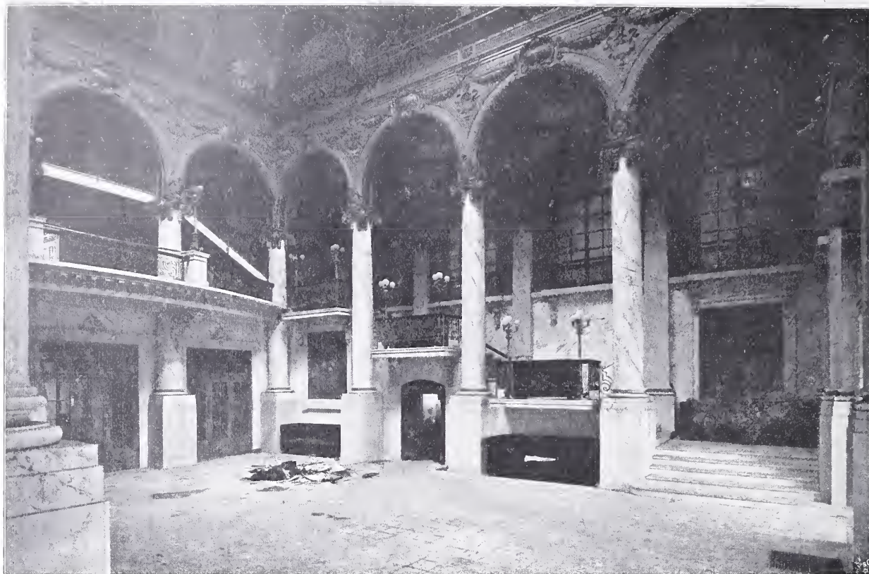
Abbildg. 5. Oestlicher Haupttreppenarm in der Treppenhalle.
