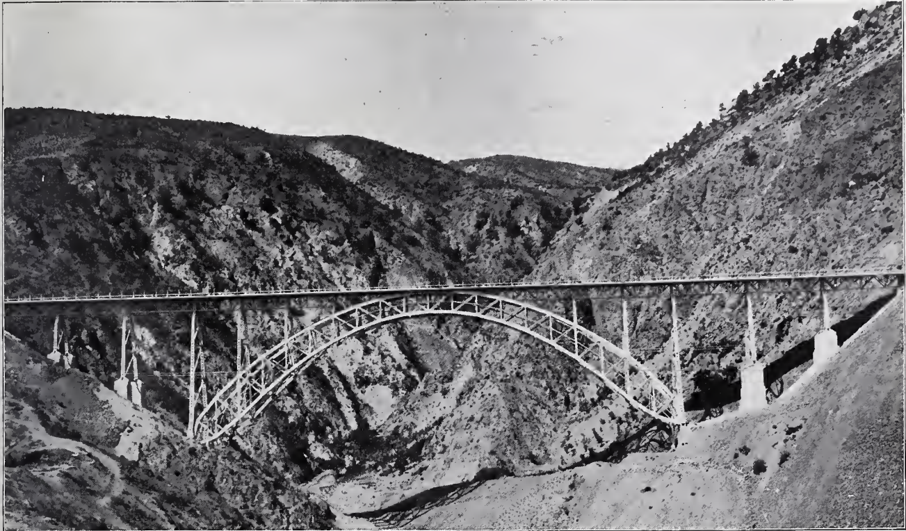
Die anatolische Eisenbahn. Abbildg. 5. Basch Keni-Viadukt.
