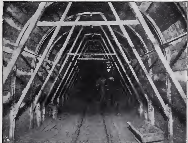
Abbildg. 3. Einblick in die eingerüstete Stollenstrecke.
