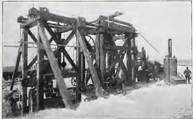
Abbildung 4. Oberes Ende der Drahtseilbahn mit der Bremsvorrichtung.
