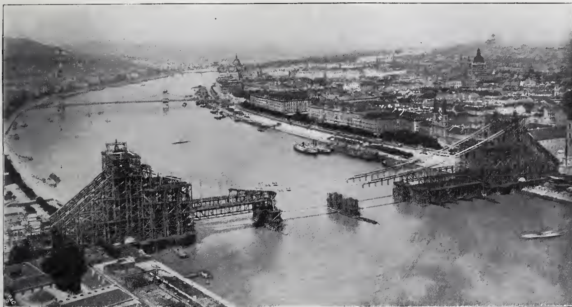
Abbildg. 22. Die Elisabeth-Brücke während der Montage. Abbau der Stromrüstungen nach Einbau der Ketten. (Photographische Aufnahme von Antal Weinwurm in Budapest.)
