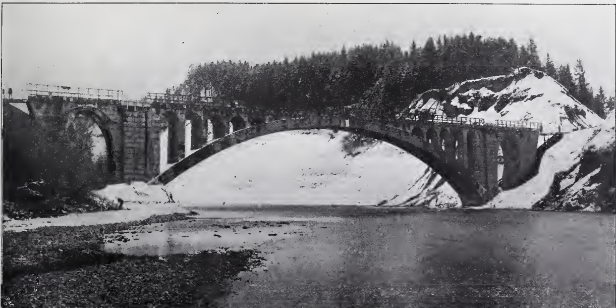
Abbildg. 1. Gesamtansicht der Brücke. (Aufnahme vom Februar 1904.)
