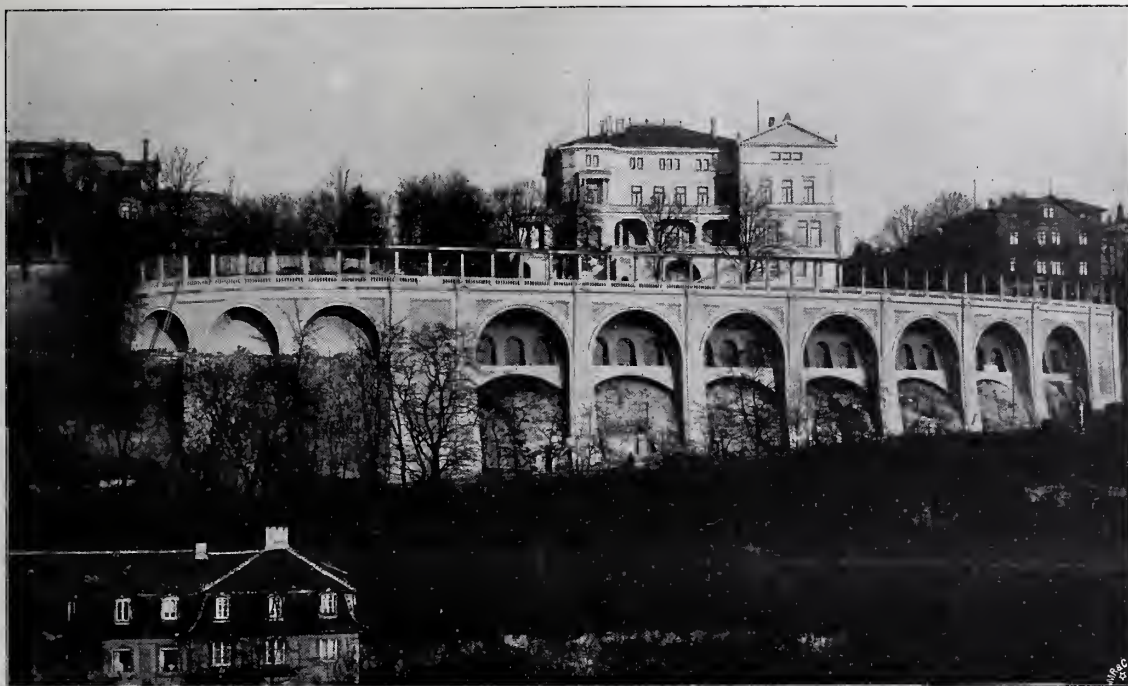
Stützmauer in Stampfbeton an der Villa Henschel in Kassel.
