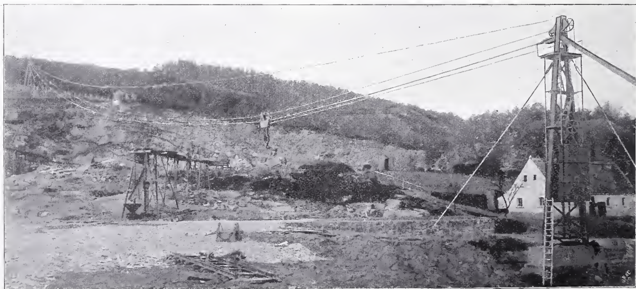
Abbildg. 20. Kabel-Hochbahnkran in Demitz bei Bautzen von Unruh & Liebig in Leipzig.
