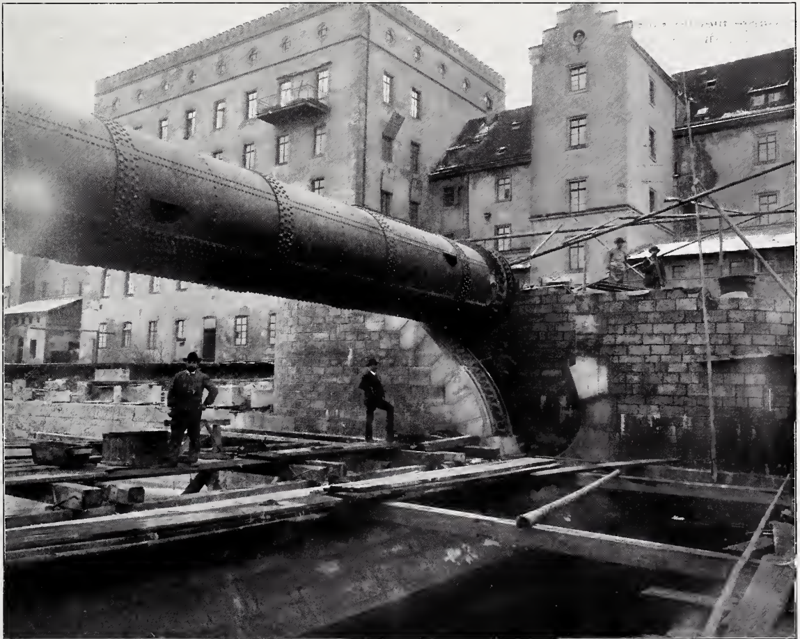
UALZENWEHR VON 35 m WEITE IM HAUPTARME DES MAINS BEI SCHWEINFURT * ENTWURF UND AUSFÜHRUNG * VEREINIGTE MASCHINENFABRIK AUGSBURG U. MASCHINENBAU-GES. NÜRN- BERG A.-G. (ZWEIGANSTALT GUSTAVSBURG BEI MAINZ) * WALZE IN HÖCHSTER STELLUNG * AUFLAGER MIT UND OHNE ANTRIEB ≡ DEUTSCHE BAUZEITUNG XXXVIII. JAHRGANG 1904 * NO. 5 ≡
