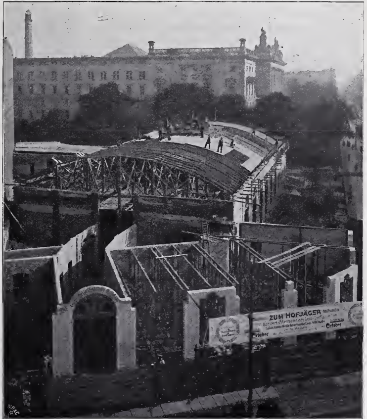
Abbildg. 3. Uebersicht der gesamten Baustelle während der Ausführung.
