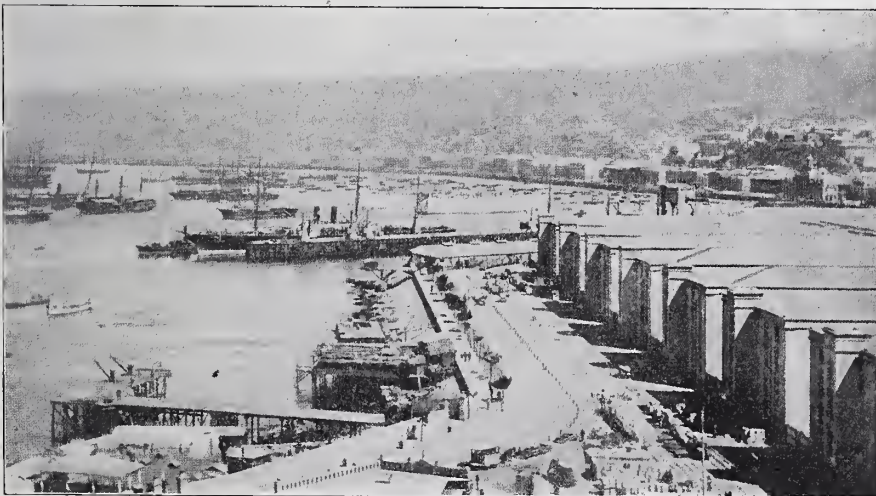
Abbildg. 5. Zollspeicher am Hafen von Valparaiso.
