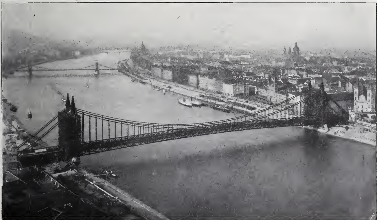
Abbildg. 10. Die Elisabeth-Brücke im Bau. (Die Montagerüstung ist bis auf die Einrüstung der Portale entfernt.)
