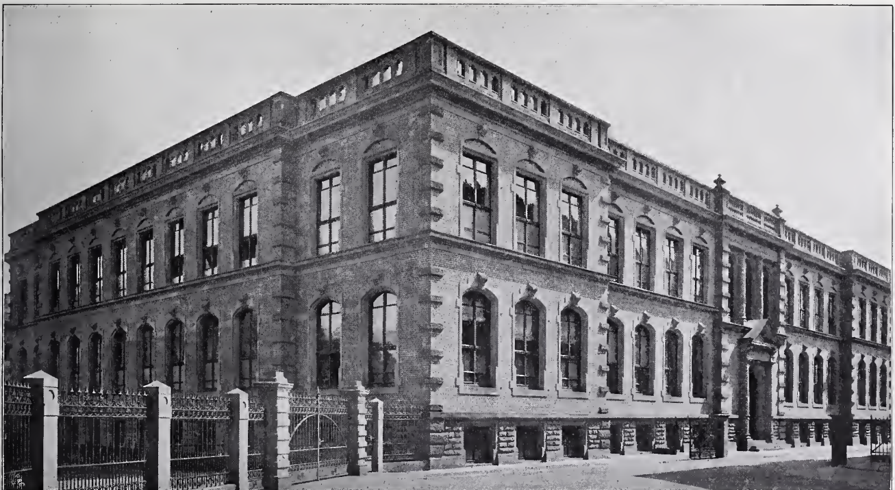
Hauptfassade gegen die Schulstraße und Nordfassade.
