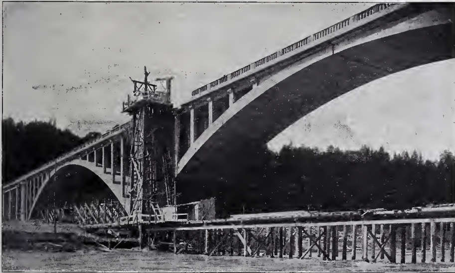
Abbildg. 20. Blick in die ausgerüsteten Gewölbe.
