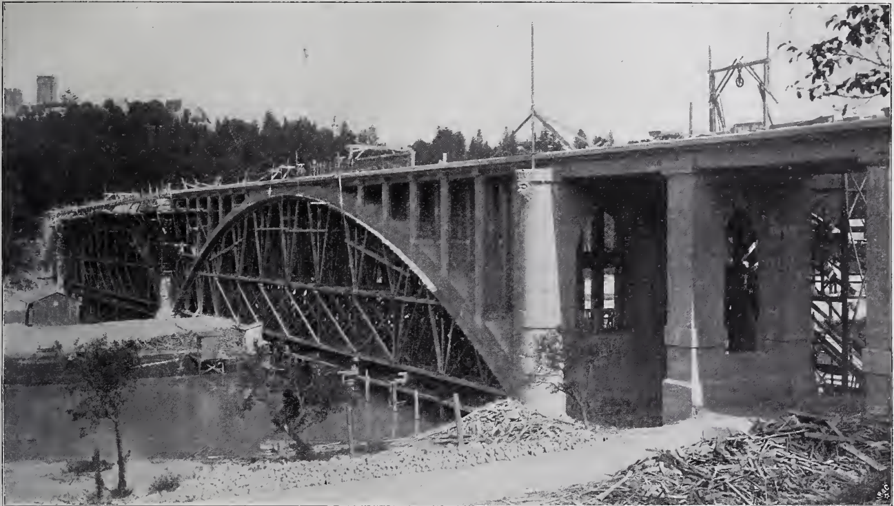
Abbildg. 9. Gesamtansicht der Brücke mit Lehrgerüst.
