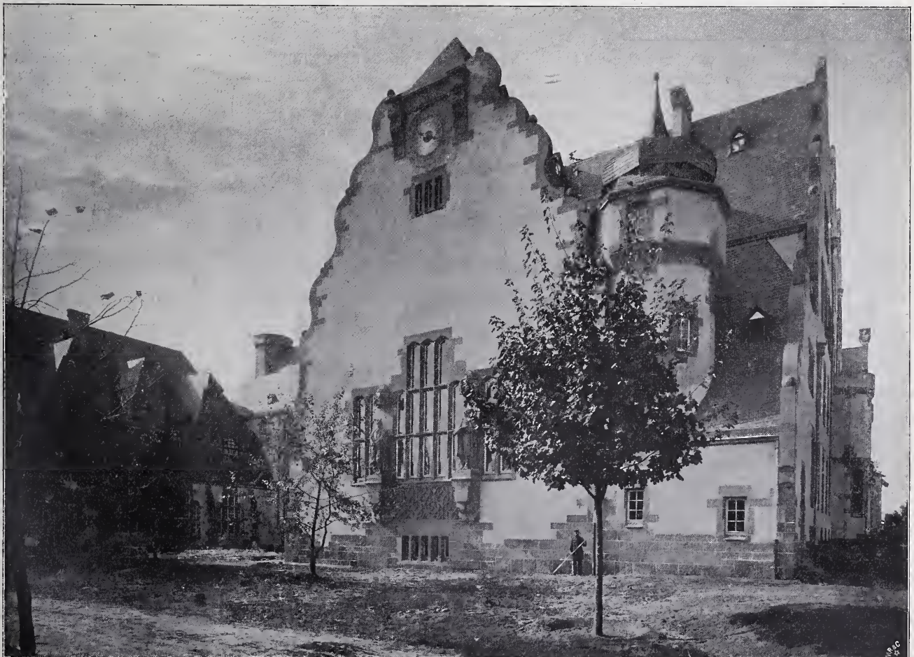
Ansicht an der Ahornstraße (Ecke Burggrafenstraße).
