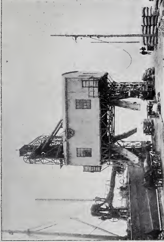
Abbildg. 28. Schiffselevator in Christiania von Amme, Giesecke & Konegen in Braunschweig.
