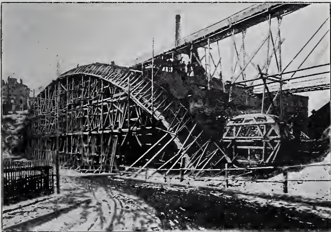
Abbildg. 11. Herstellung des Gewölbes auf dem Lehrgerüst.
