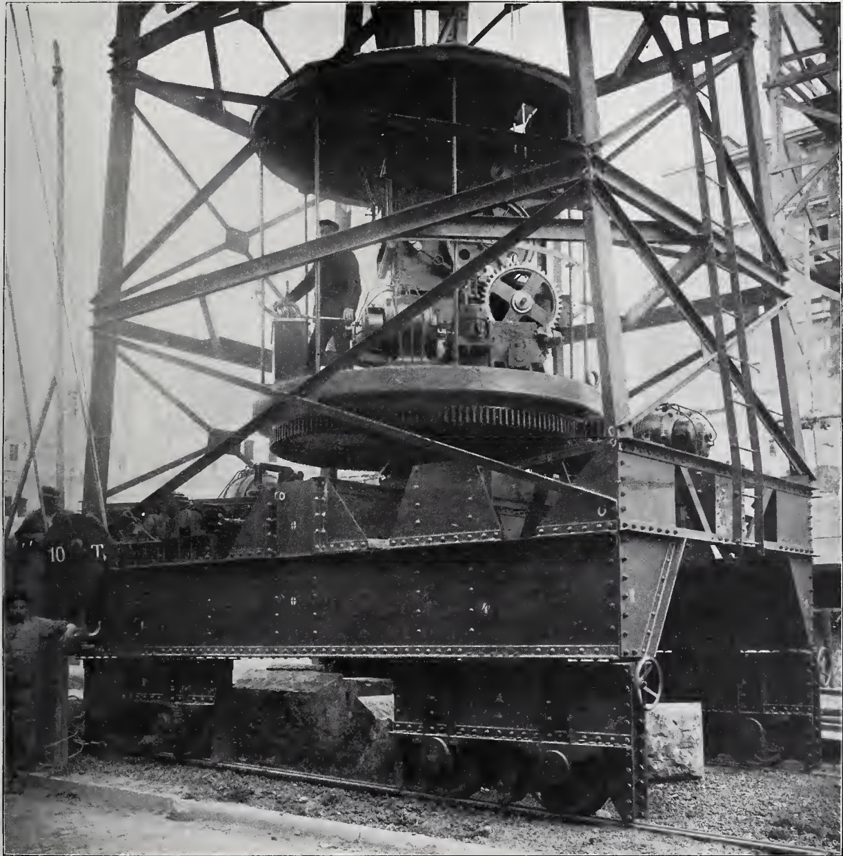
Elektrischer Turmkran zur Ausführung von Hochbauten.
