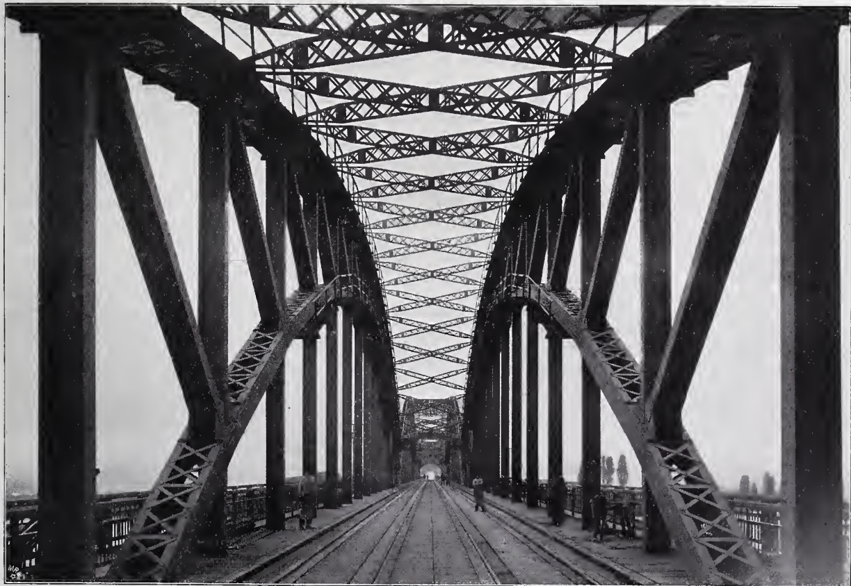
Die neue Eisenbahn-Verbindung über den Rhein bei Mainz. Abbildg. 6. Einblick in die Strombrücke.
