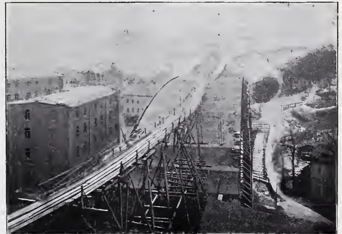
Abbildg. 12. Blick auf den Gewölberücken des fertiggestellten Hauptbogens mit Transportgerüst.
