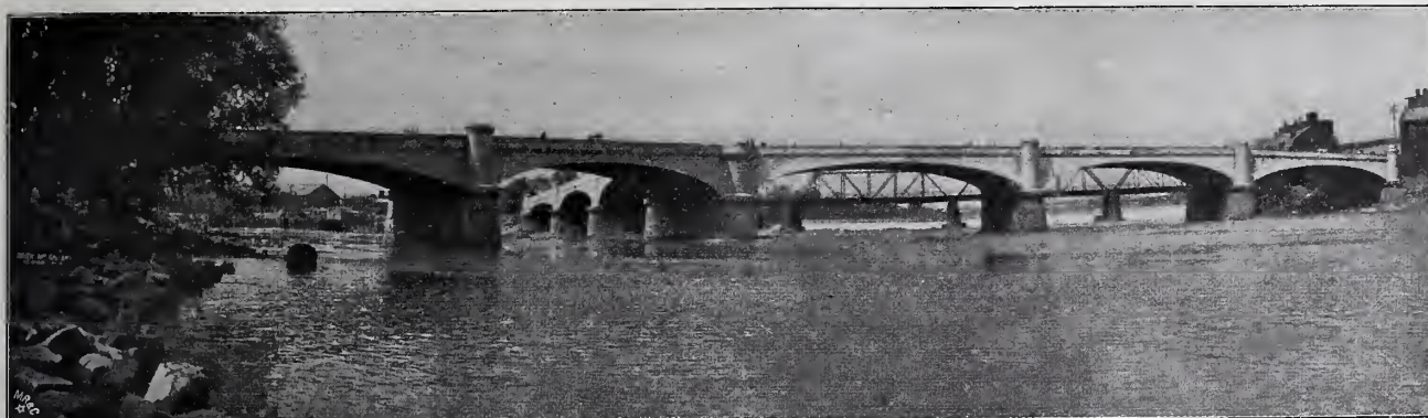
Abbildg. 1. Dreiarmige Eisenbetonbrücke in Zanesville, Ohio, V. St. von Nordamerika.
