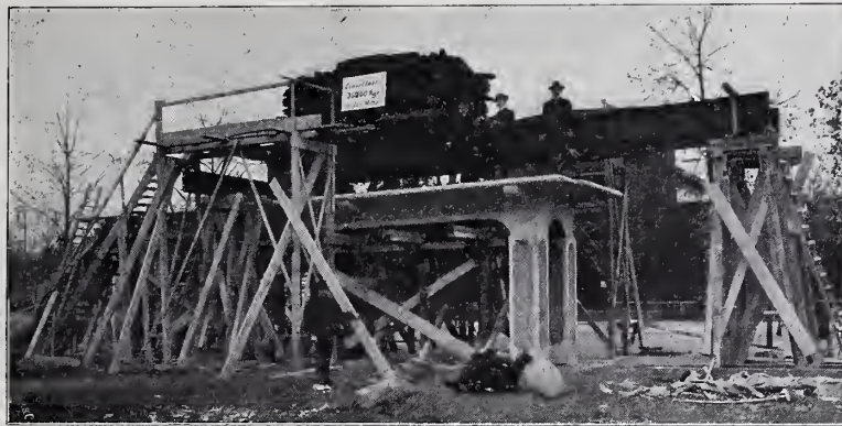
Die Brücke während des Bruchversuches.
