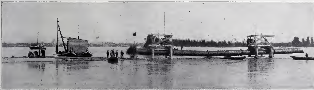
Abbildg. 8. Versenkung des Schmutzwasser-Rohres im Rhein.
