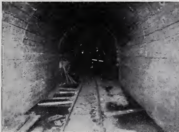
Abbildg. 1. Einblick in die fertig ausgebaute Stollenstrecke.
