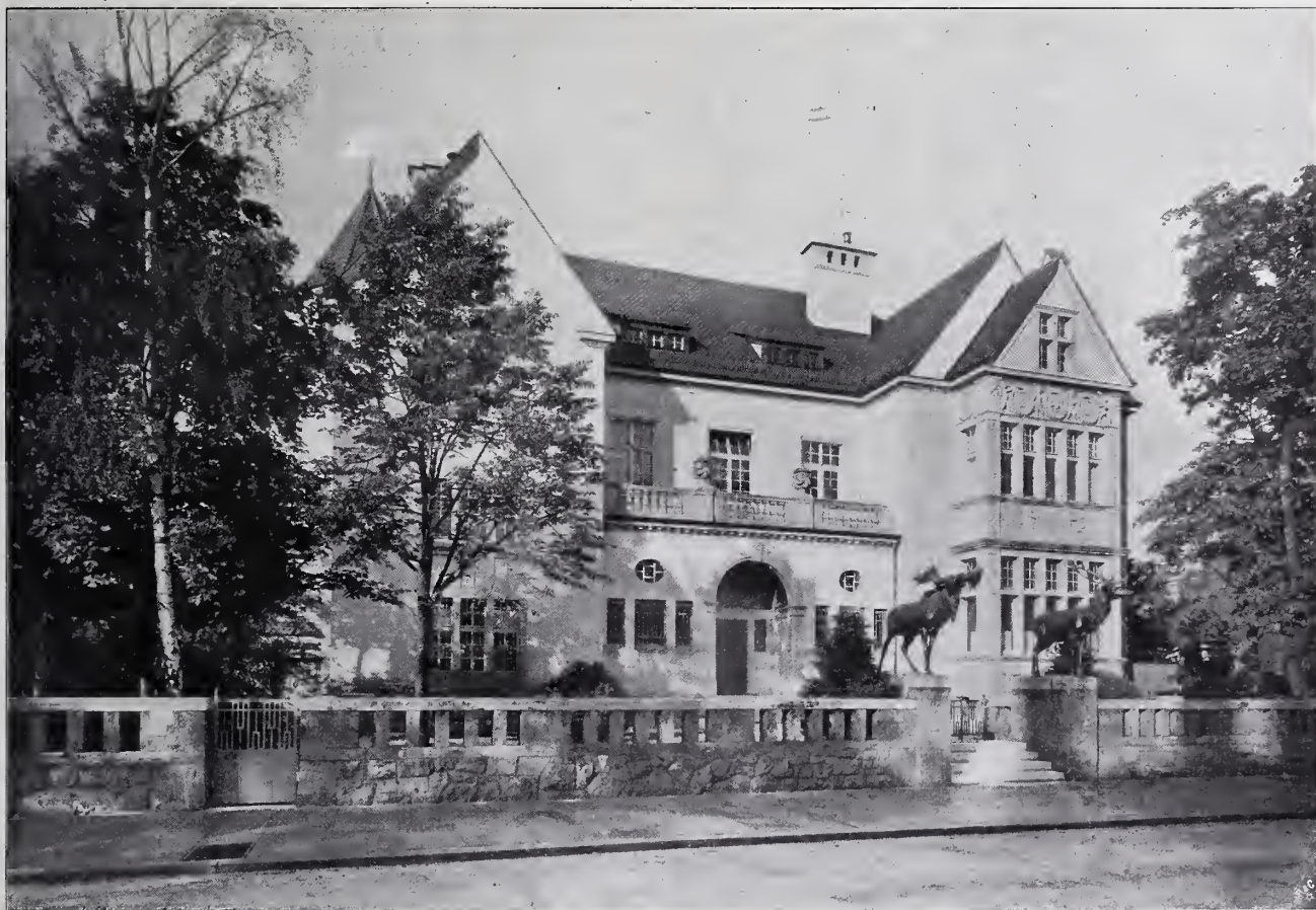
Der „Lindenhof“, Wohnhaus des Herrn Arch. Prof. M. Littmann in München-Bogenhausen. Straßensicht.
