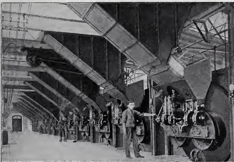
Abbildg. 41. Kohlensilo-Auslauf in einem Kesselhaus. Unruh & Liebig, Leipzig.
