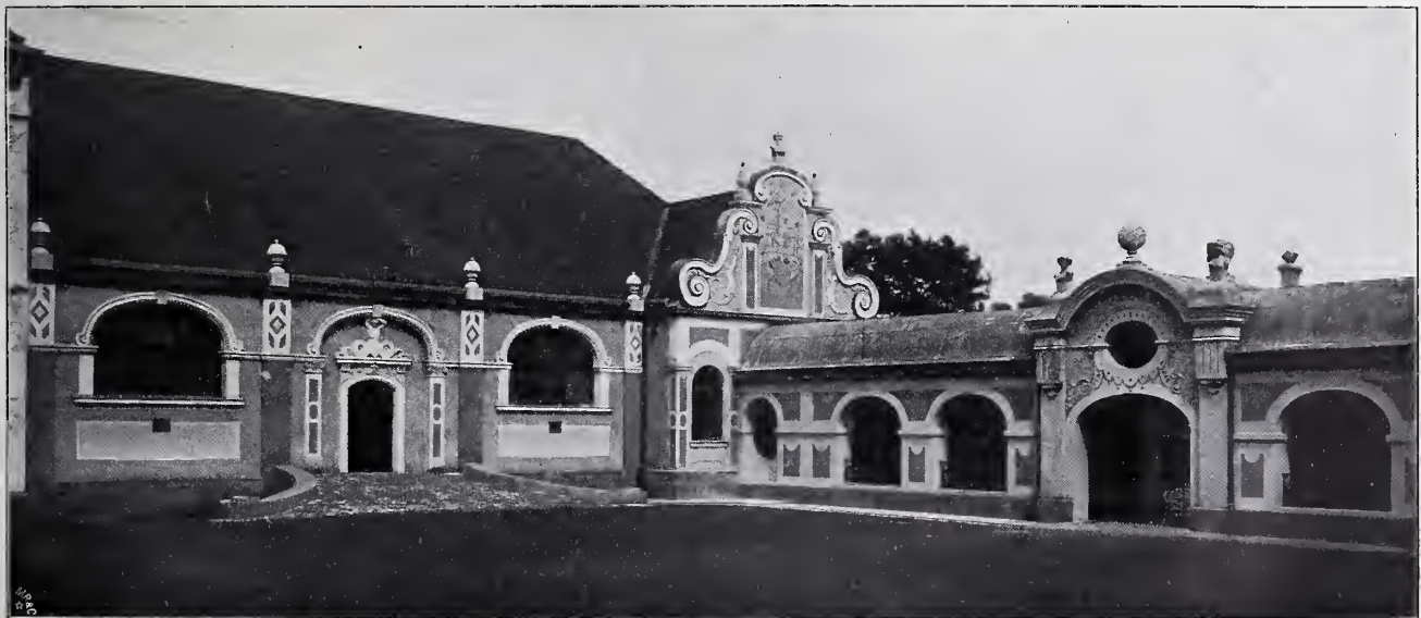
Hofansicht mit der Turnhalle und dem Verbindungsgang.
