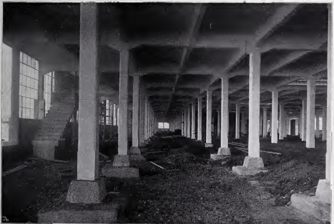
Fabrikbau der „Daimler-Motoren-Gesellschaft“ in Unterturkheim. Eisenbetonbau ausgef. von Ways & Freytag in Neustadt a.H.
