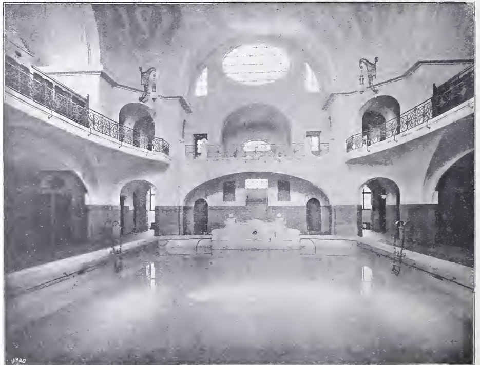
Ansicht des Frauen-Schwimmbades.
