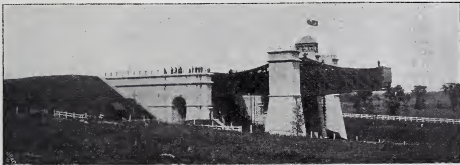
Abbildung 1. Gesamtansicht des Hebewerkes bei Peterborough im Trent-Kanal (Kanada).
