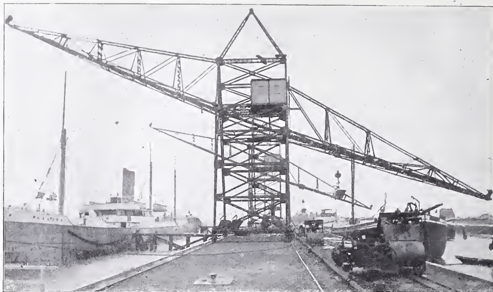
Abbildg. 18. Verladeanlage für die Firma de Porter in Rotterdam von Pohlitz A. G. in Köln.
