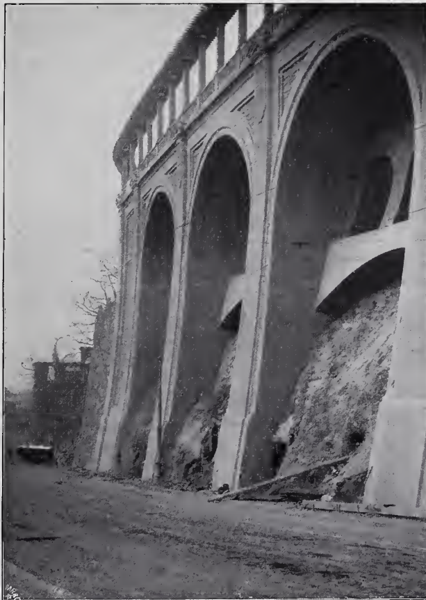
Abbildg. 1. Teilansicht der fertigen Mauer.
