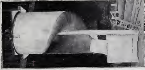
Abbildg. 32. Wendelrutsche von R. W. Dinnendahl A.-G. in Steele a. R.
