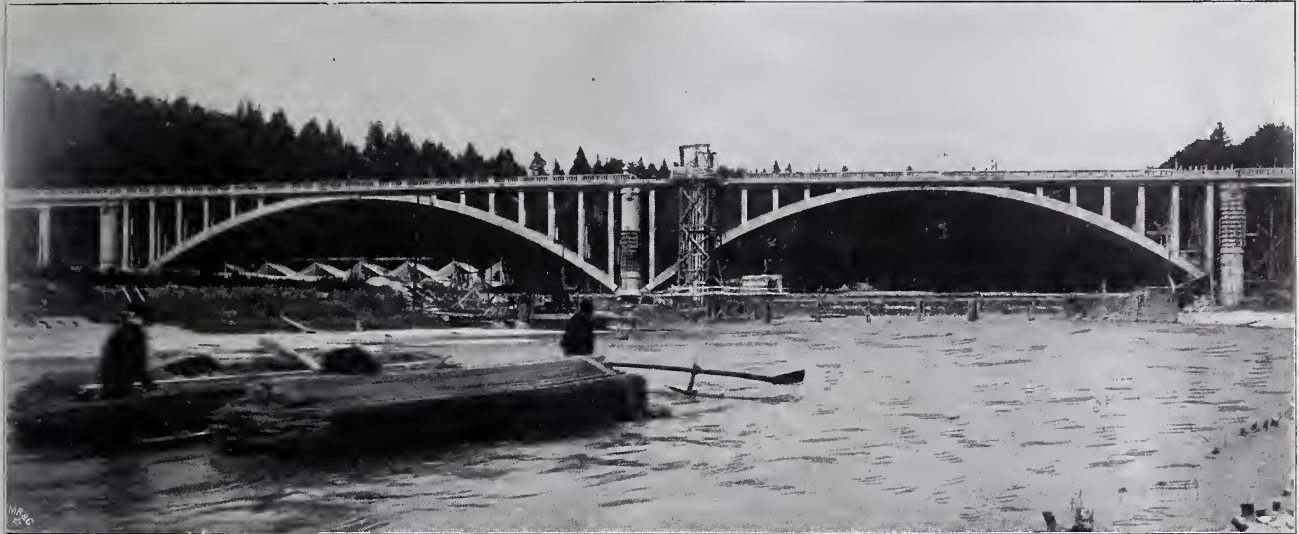
Abbildg. 1. Ansicht der Brücke nach der Ausrüstung.
