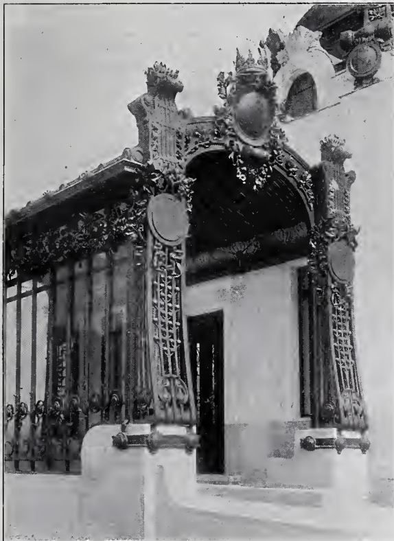
Unterfahrt des k. u. k. Hofpavillons der Stadtbahn bei Schönbrunn bei Wien.
