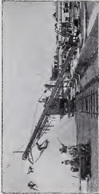
Abbildg. 22 u. 23. Salz-Transportband mit fahrbarem Motor.
