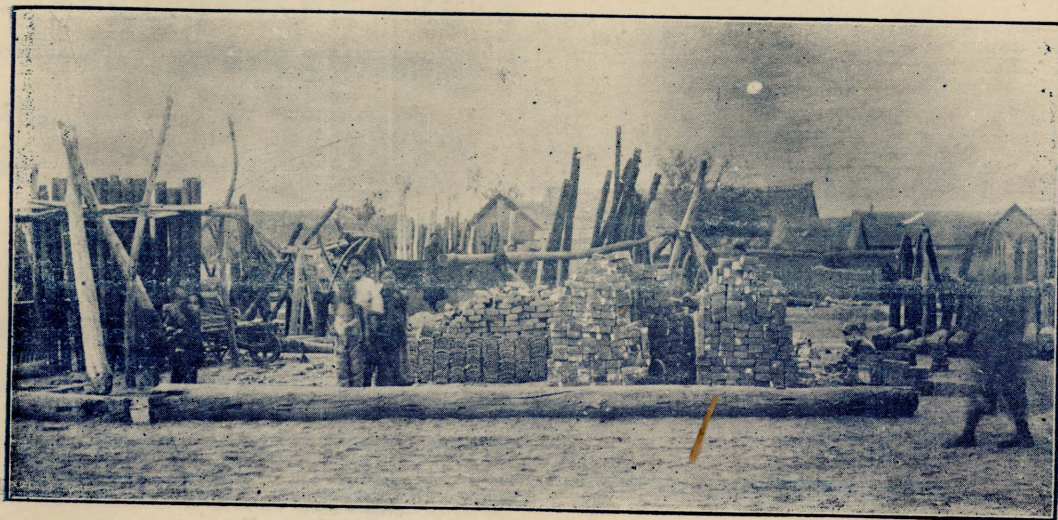
河南鄆城縣災民扒賣房屋之狀況
