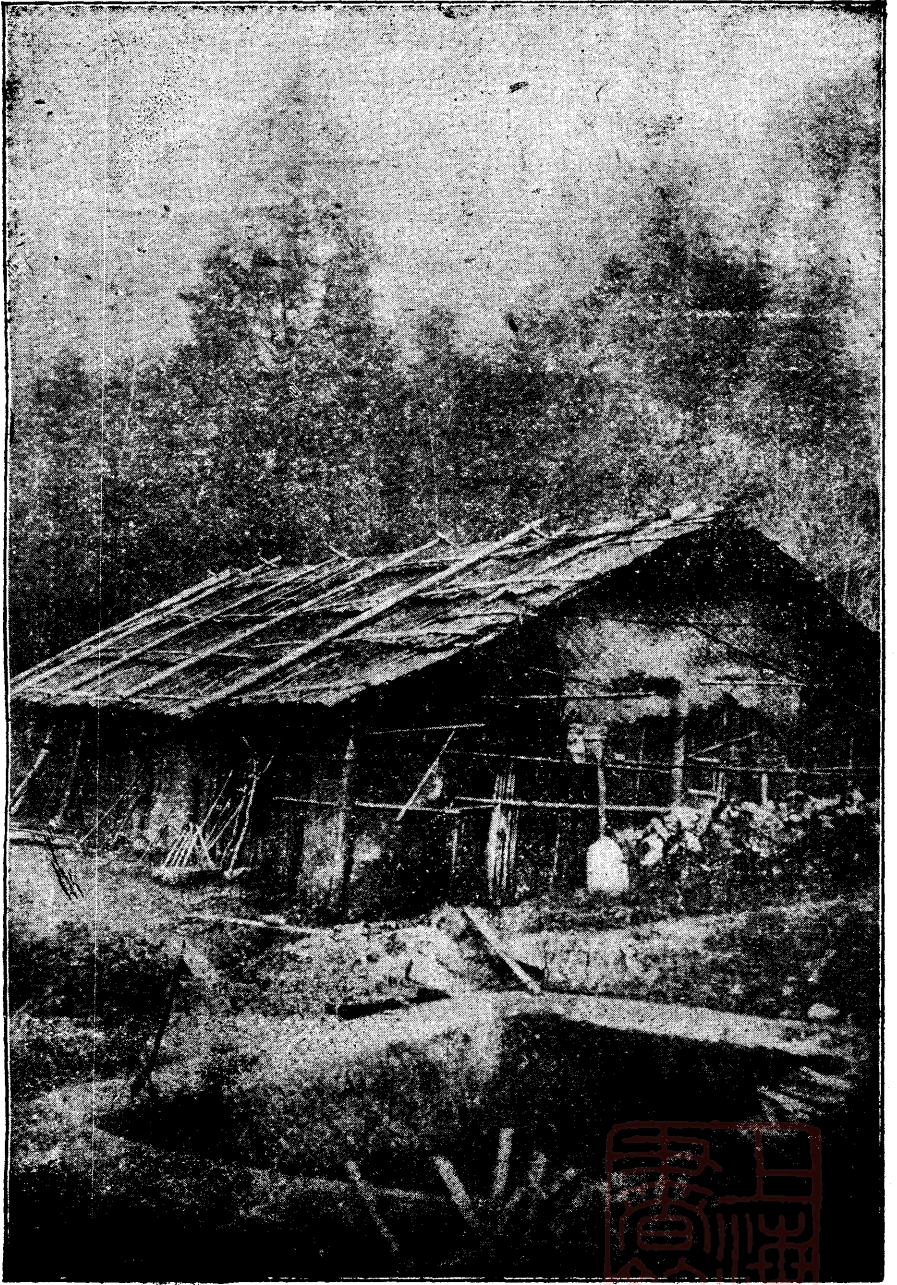
圖：這個紙場，叫做石和寺，位置在茶園山邊。四圍用杉支撐着，瓦面是用竹枝石頭夾着樹皮。牆壁用竹枝和樹皮造成。
