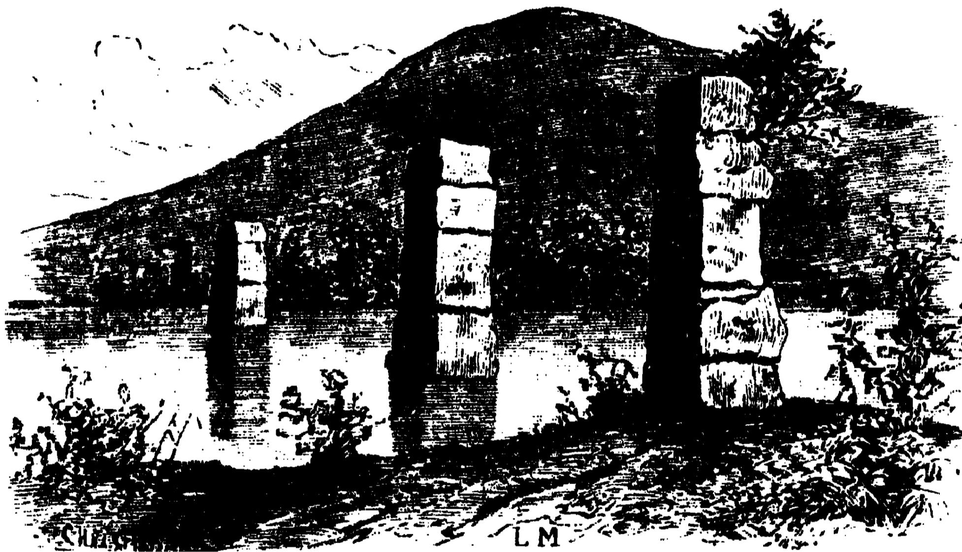
RUINAS DA PONTE SOBRE O RIO NEGRO
