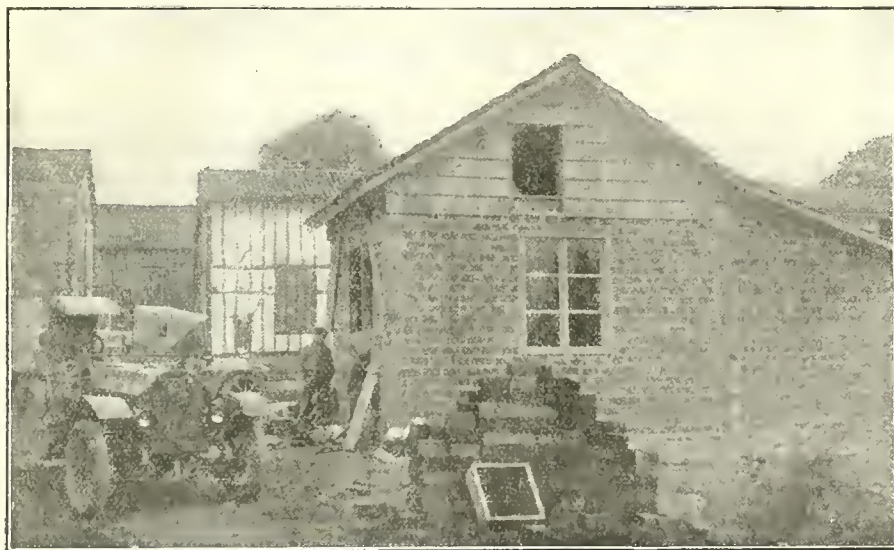
Fig. 13. — Abris en briques et planches élevés par la Société des Amis de Londres.
