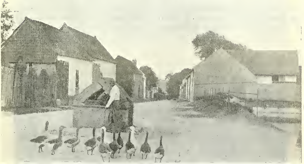
Fig. 70. — Autre exemple de constructions agricoles en Picardie.
