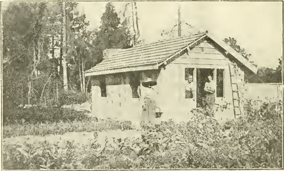
Fig. 12. — Abri en planches presque terminé, à Blesmes (Marne.)
