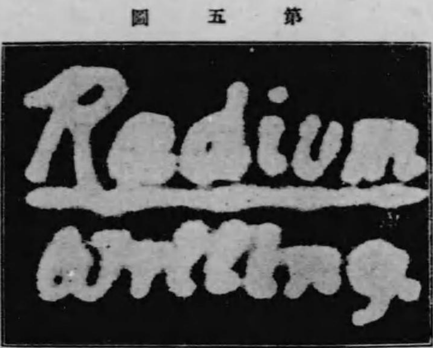
本圖は寫眞の乾板を黒布にて覆ひ全光線を 斷絶したる者の上に臭化ラヂウム」の少量 を入れたる硝子管にて文字を書きたるもの を現像したる寫眞なり。
