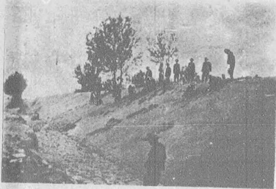
修補第四壩完工情形
