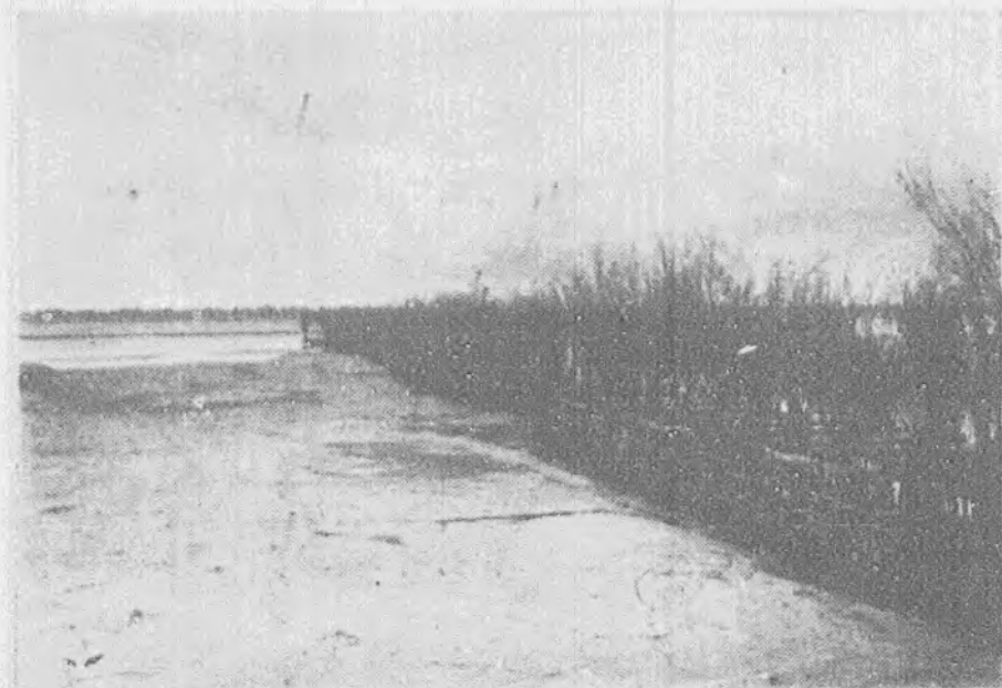
南第二段透水壩上下游淤高成灘
