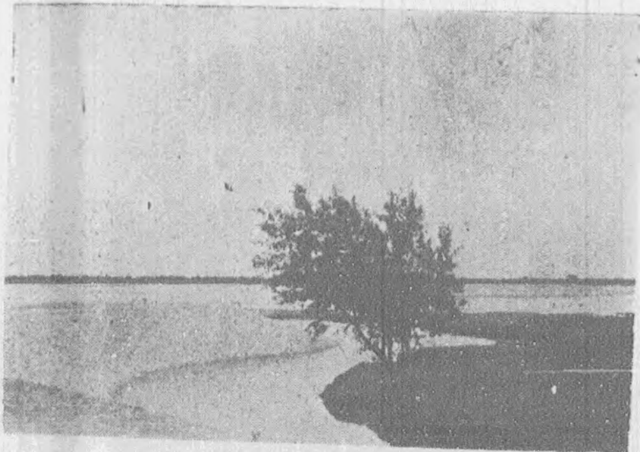
南三石壩頭修理後經汛水完整無損 大溜已趨河中
