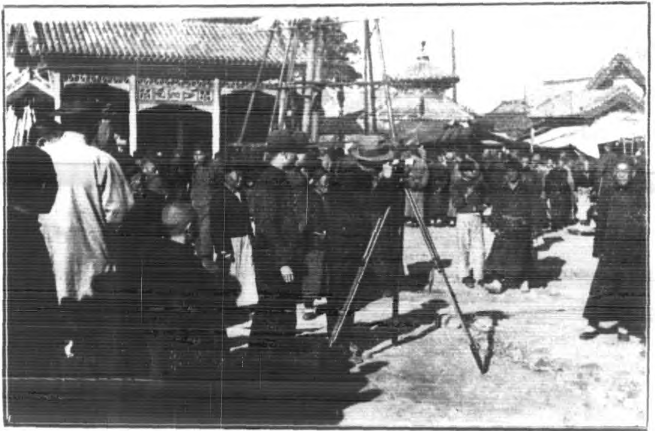
約突泉水源地測量工作
