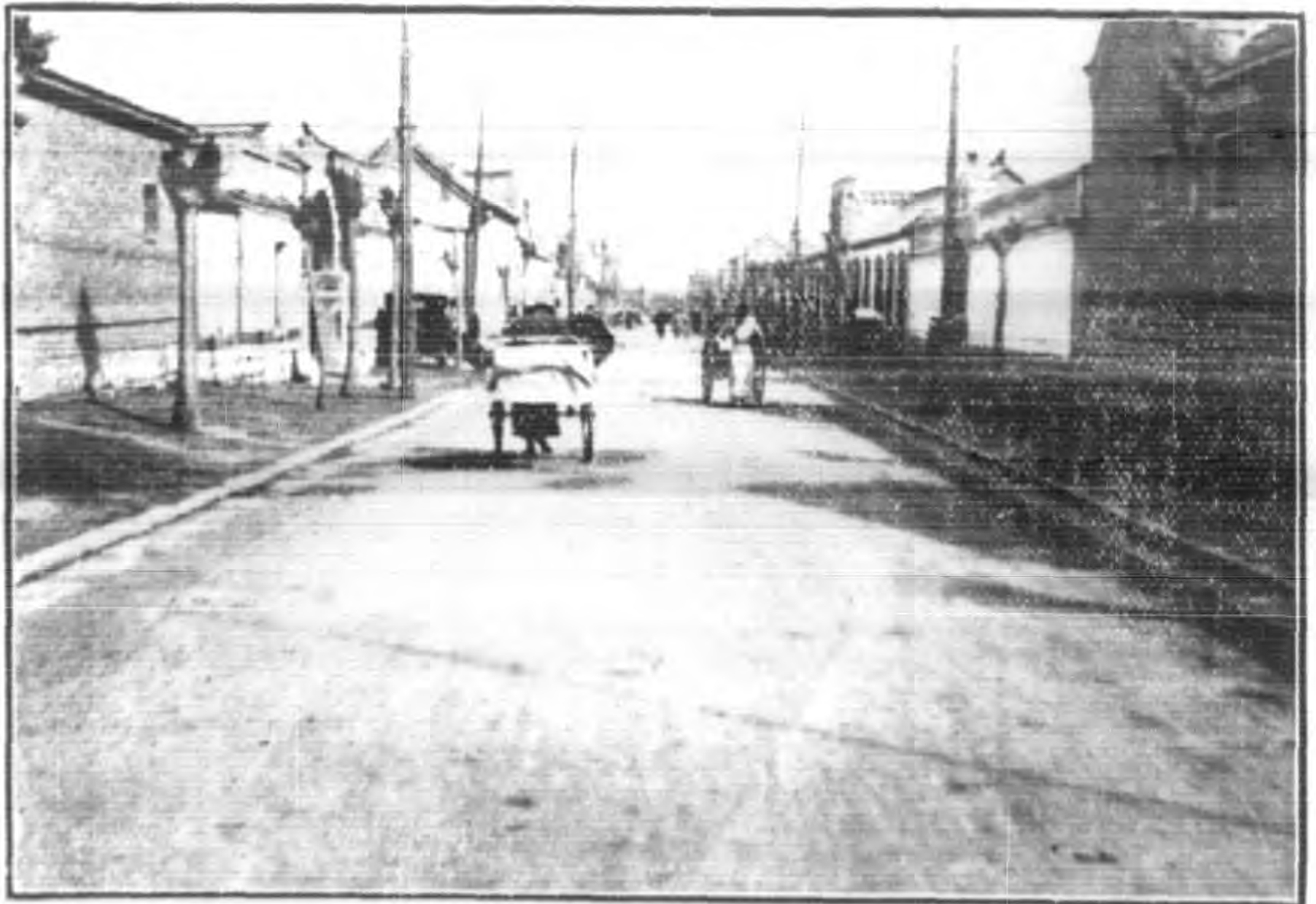
(二) 翻修緯八路工程完竣
