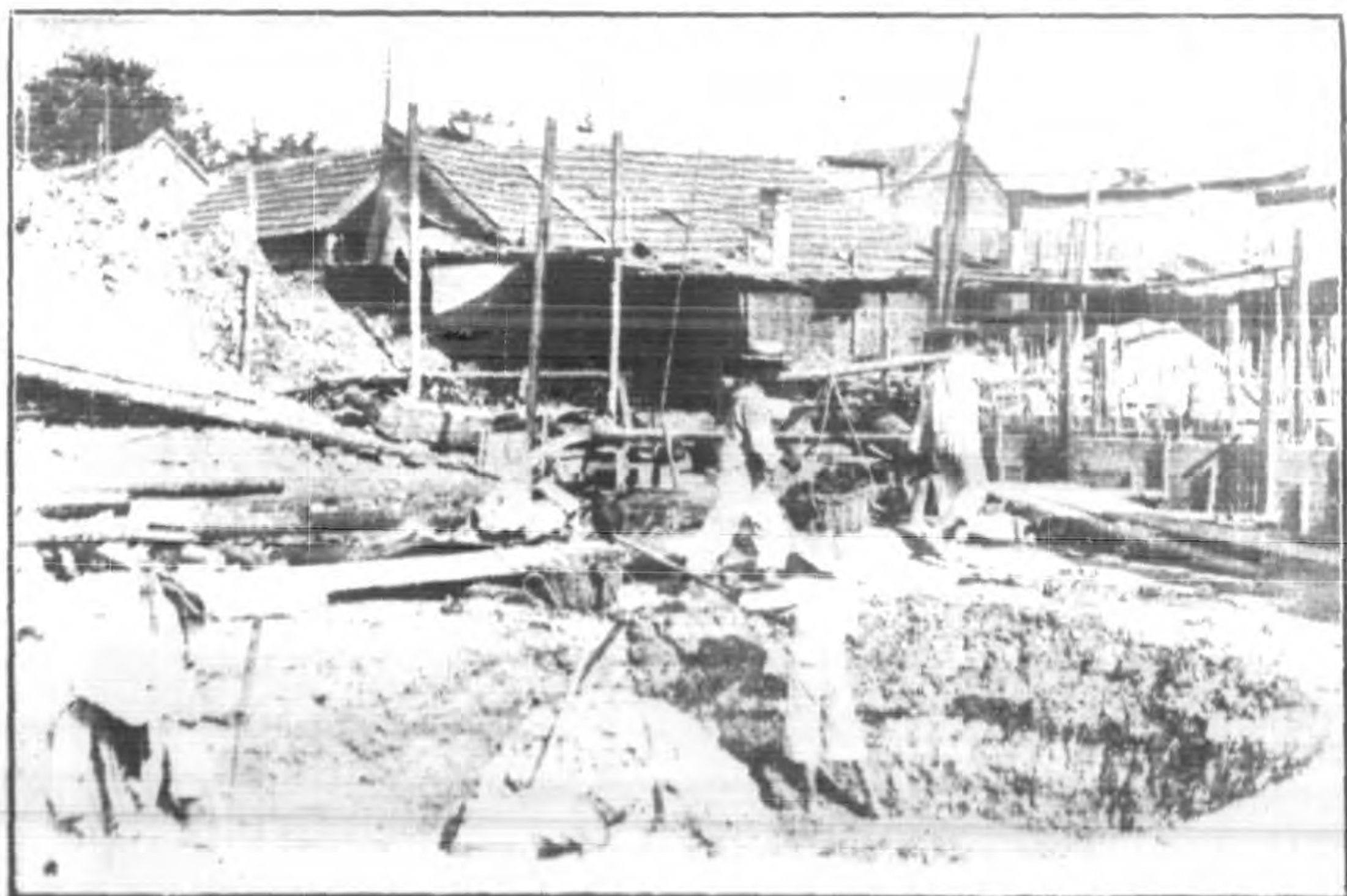
(六) 沉沙井初步挖土工作
