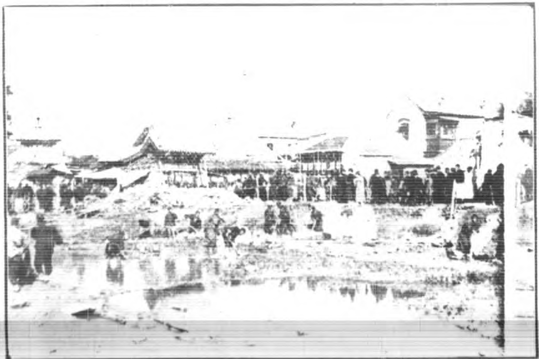
(八) 蓄水池中進行土工作
