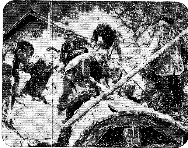
保靖县毛沟公社拱桥大队党支部书记李叶轩（左前二）和社员一道，凿石拱桥，建设平展展的农田。
