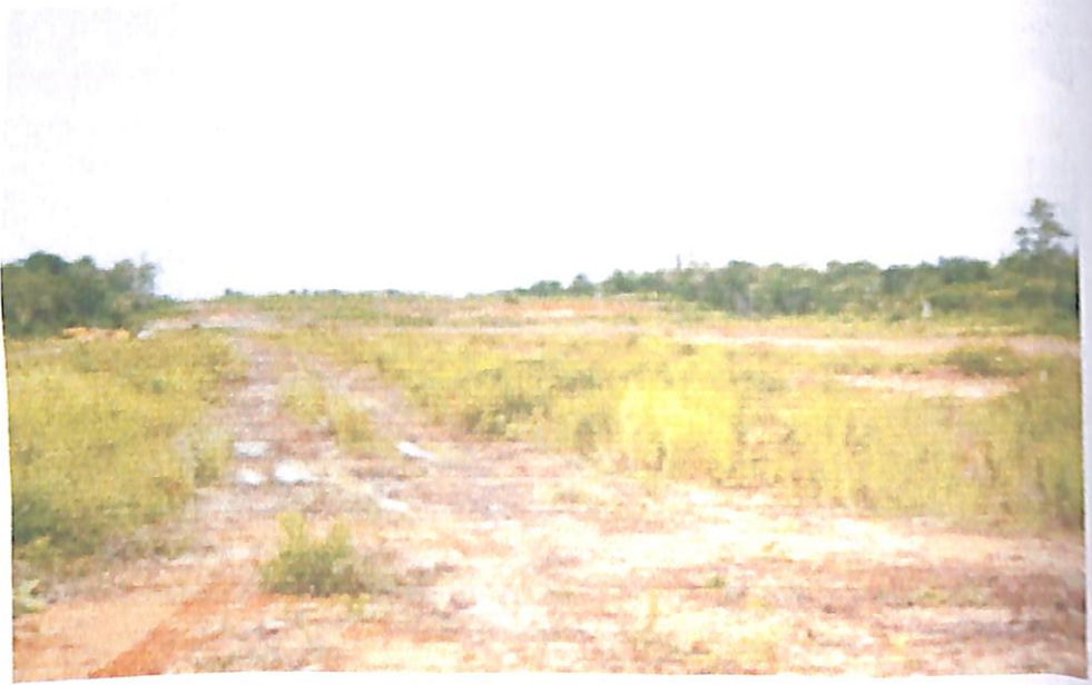
Foto 7. Pembangunan landasan pacu bandara perintis di Miau Baru (Foto: M. Nanang)
