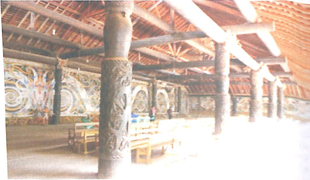
Foto 5. Kondisi ruangan bangunan Lamin (Foto: A. Anzieb)
