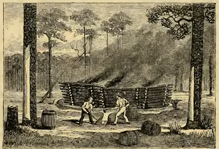
Fig. 6.—BURNING A TAR KILN.
