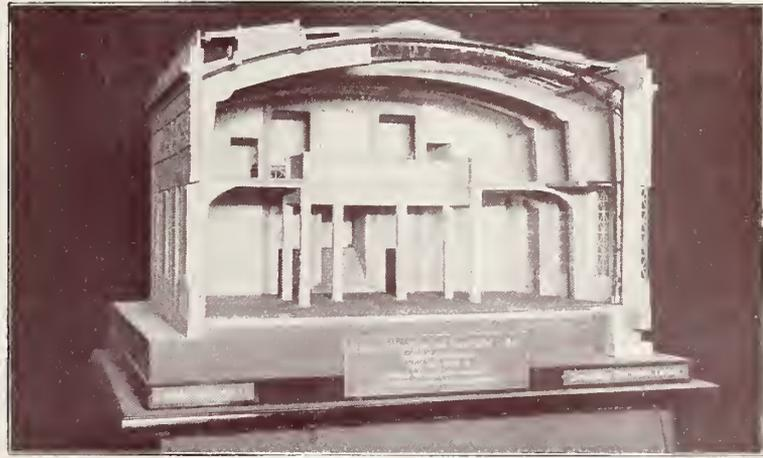
Modell der Kuppelhalle (Querschnitt m. Lehrgerüst).
