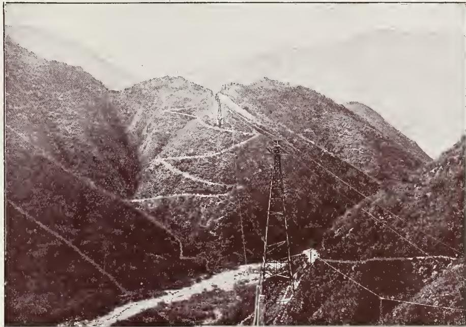
Kordilleren-Bahn. Ansicht der Strecke zwischen Rodeo de las Vacas und Cueva de Romero mit Stütze von 50 m Höhe.
