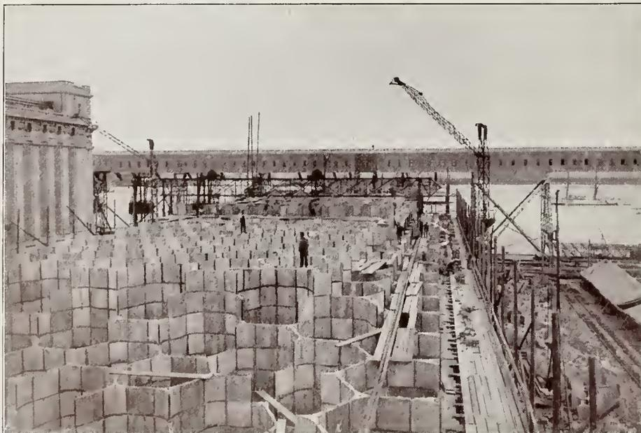
Getreidesilo in Konstanz. Herstellung der Silozellen aus vorher gefertigten Eisenbetonplatten.
