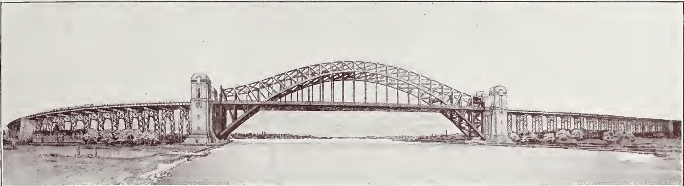
Hell-Gate-Brücke über den East River, New-York.\* Spannweite 305 m, lichte Höhe über dem Wasserspiegel 43 m, Höhe der Türme 61 m.
