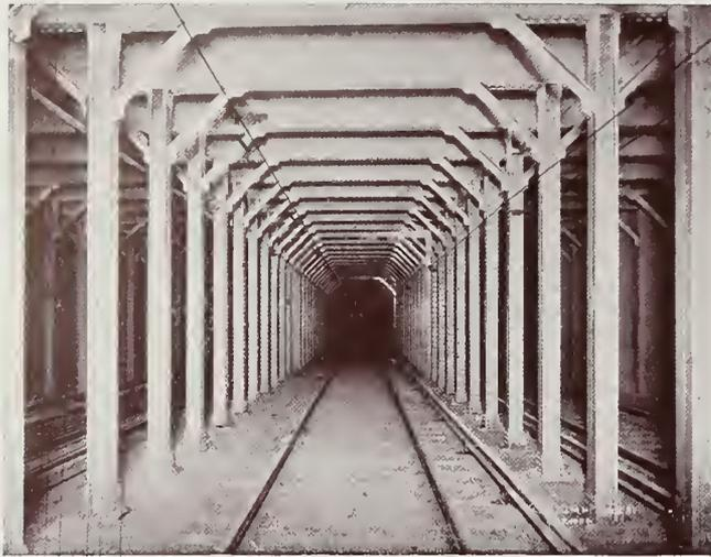
◦◦ Eisenkonstruktion der New-Yorker Untergrundbahn. ◦◦
