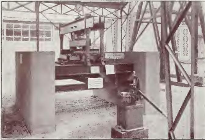
Abb. 4. Hof. Transportable Vorrichtung zur Belastung von
