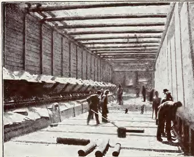
Untergroundbahn Berlin—Schöneberg. Aufbringen der dreifachen Dichtung der Tunnelsohle auf die wagerechte Betonunterlage. ○ ○ ○ ○
