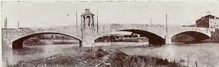
Camsdorfer Brücke über die Saale in Jena. Dreigelenkbogen, 3 Öffnungen, 30, 33 und 30 m Spannweite, Breite 16 m, Stampfbeton mit Muschelkalkstein-Verkleidung.
