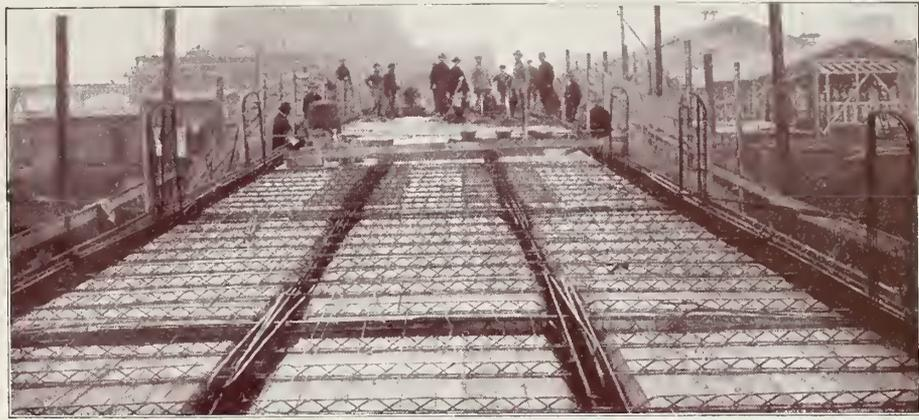
..... Abb. 5. Platte vor dem Einbetonieren. ....
