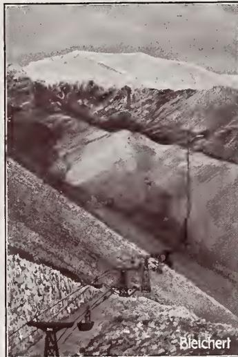
Kordilleren-Bahn. Oberste Strecke der aus 8 Sektionen bestehenden Drahtseilbahn von 3600 m Gefälle und 35 km Länge bei La Mejicana (Argentinien).
