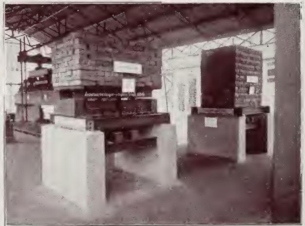
Abb. 5. Hof. Ermittlung der Tragfähigkeit von Massivdecken bei gleichmäßiger Lastverteilung. Rechts: Falsche Versuchsanordnung, da die Ziegelsteine sich gegenseitig stützen und ihre Last auf die Decke nicht voll zur Wirkung gelangt. Links: Richtige Versuchsanordnung, da der Zwischenbau aus eisernen Trägern gleichmäßige Lastverteilung gewährleistet. ....
