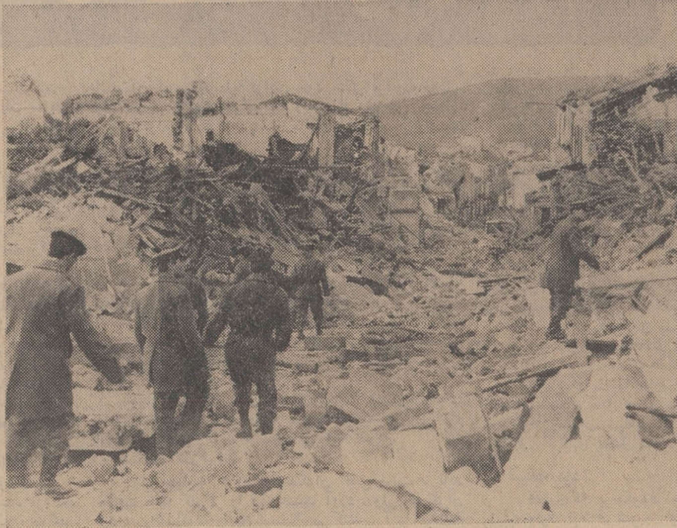
صحنه ای از منظره زلزله زده
