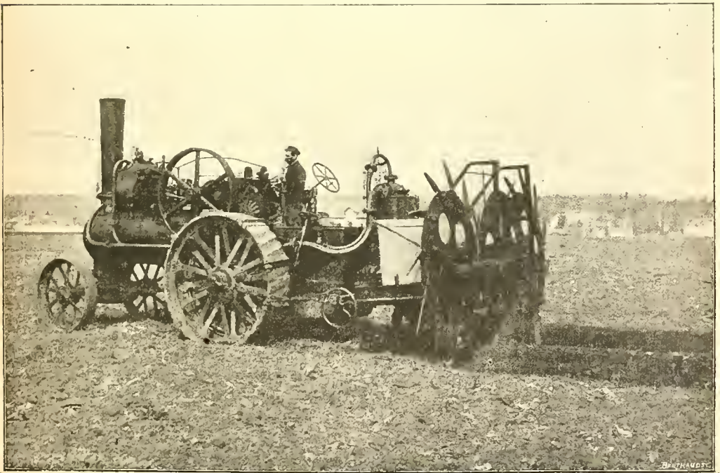
Fig. 50. — Vue générale de la charrue rotative automotrice Boghos Pacha Nubar.
