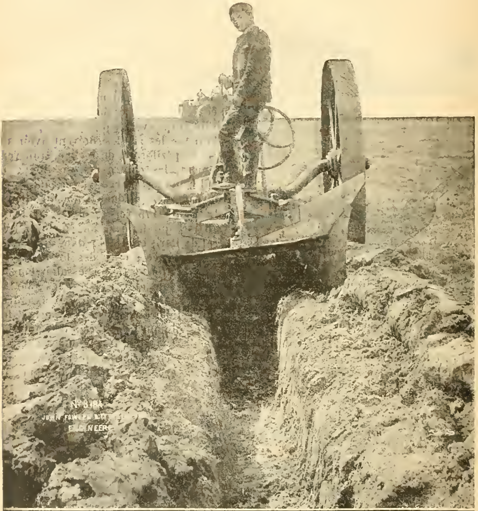
Fig. 176. — Rigoleuse à vapeur (Fowler).
