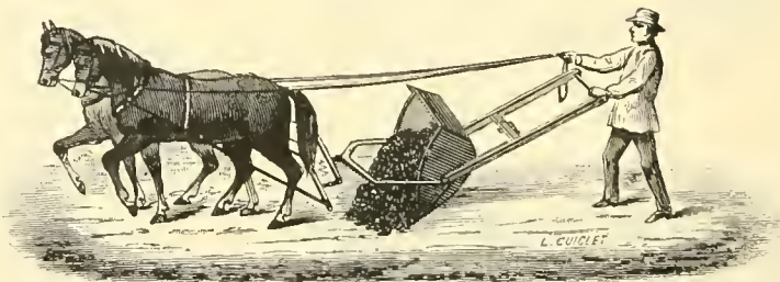
Fig. 143. — Ravale Garnier. — Période de déchargement.
